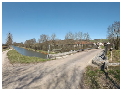
Le pont. Phot. Thierry Kuntz IVR26_20122102742NUC4A
