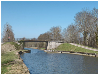
Le pont. Phot. Thierry Kuntz IVR26_20122102740NUC4A
