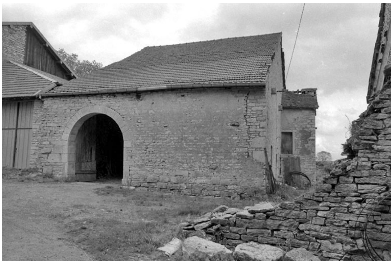
Façade latérale gauche sur rue.
