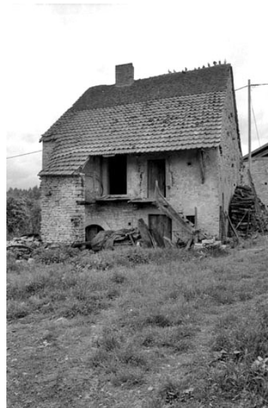
Habitation annexe sur cave. Phot. Bernard Lardière IVR43_19817000902Z
