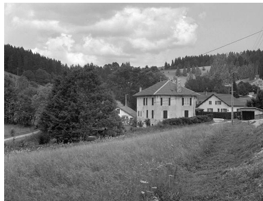
Vue de situation. Phot. Jérôme Mongreville IVR43_20003900313X
