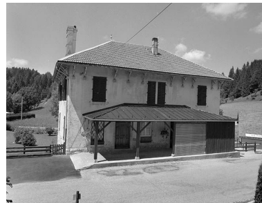
Façade antérieure. Phot. Jérôme Mongreville IVR43_20003900312X
