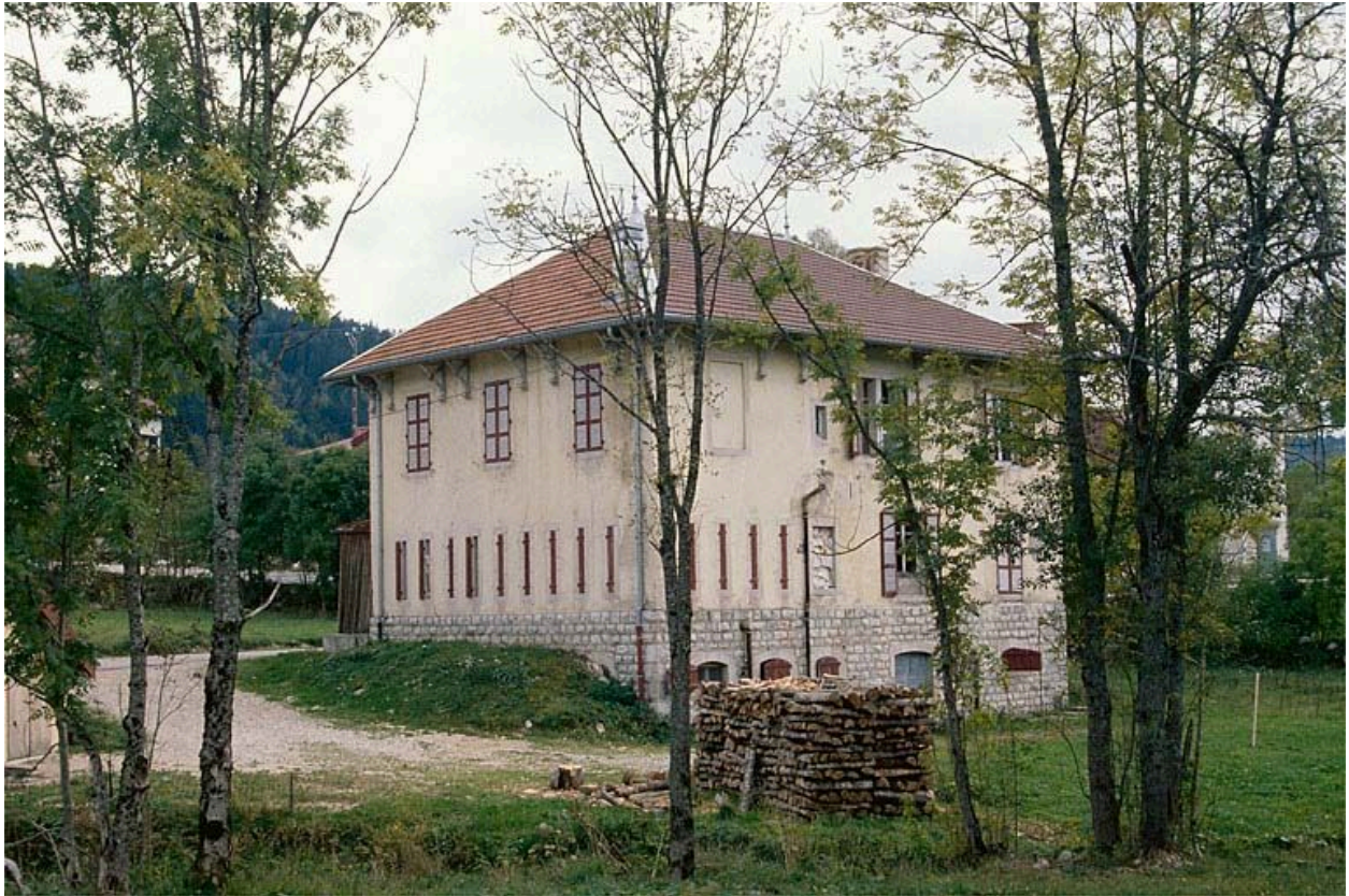
Face droite et façade postérieure vues de trois quarts.
