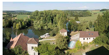
Les bâtiments des communes dans la basse cour, depuis le toit-terrasse du donjon du château, la Saône et le Durgeon. Phot. Sonia Dourlot IVR43_20167001462NUC4A
