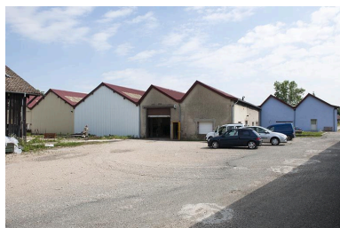
Pignons sud de l'atelier de fabrication. Phot. Jérôme Mongreville IVR43_20112501232NUC4A
