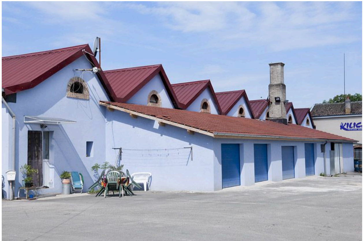
Pignons de l'atelier de fabrication.
