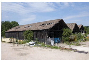
Entrepôt industriel. Phot. Jérôme Mongreville IVR43_20112501231NUC4A
