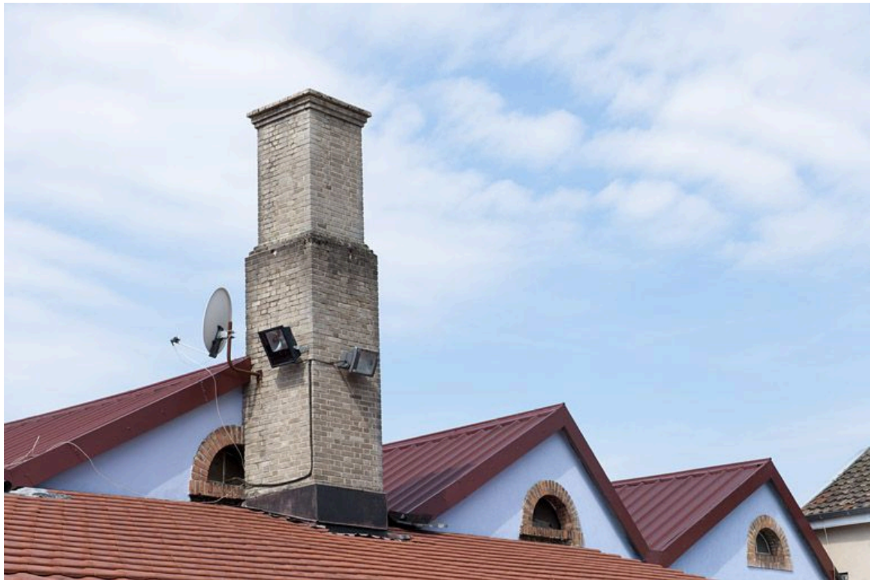
Détail de la cheminée de l'ancienne chaufferie.
