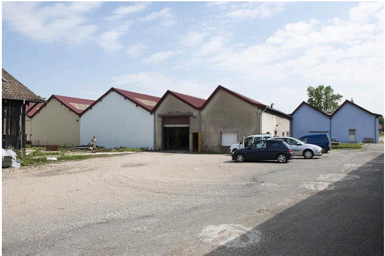
Pignons sud de l'atelier de fabrication.
