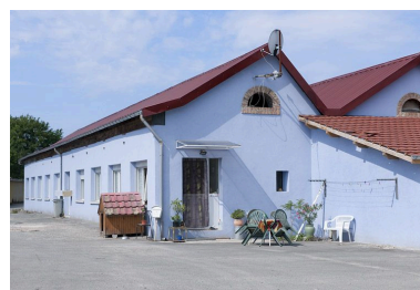
Travée est de l'atelier de fabrication. Phot. Jérôme Mongreville IVR43_20112501227NUC4A
