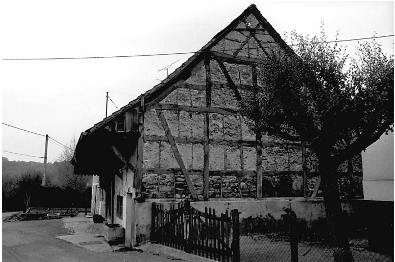
Vue du pignon droit.
