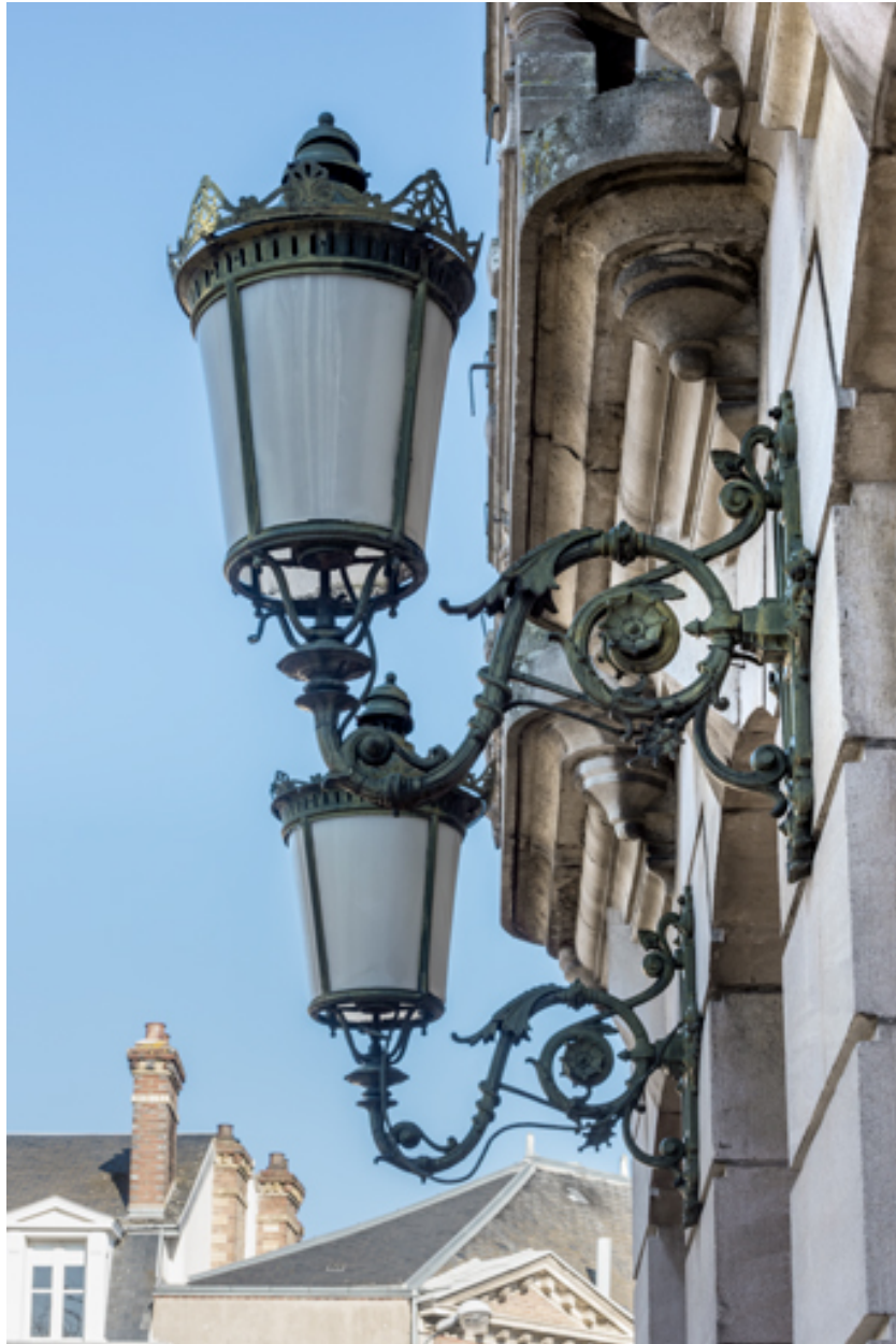
Luminaires d'applique en façade, vus de profil.
