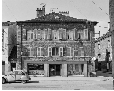
Façade sur la rue de la République, vue de face. Phot. Yves Sancey IVR43_19802500298X
