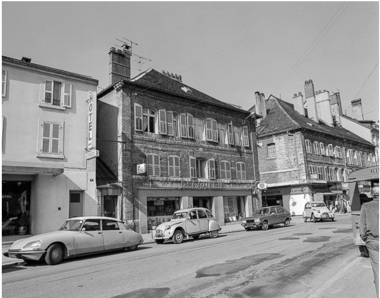
Façade sur la rue de la République, vue de trois quarts gauche.
