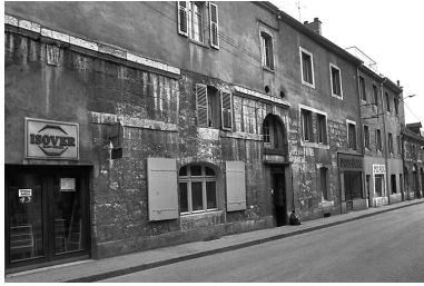
Façade sur la rue Montrieux. Phot. Yves Sancey IVR43_19802500297X
