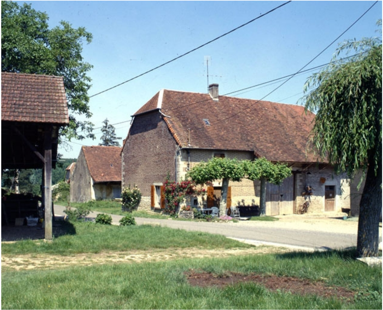
Façades antérieure et latérale gauche.
