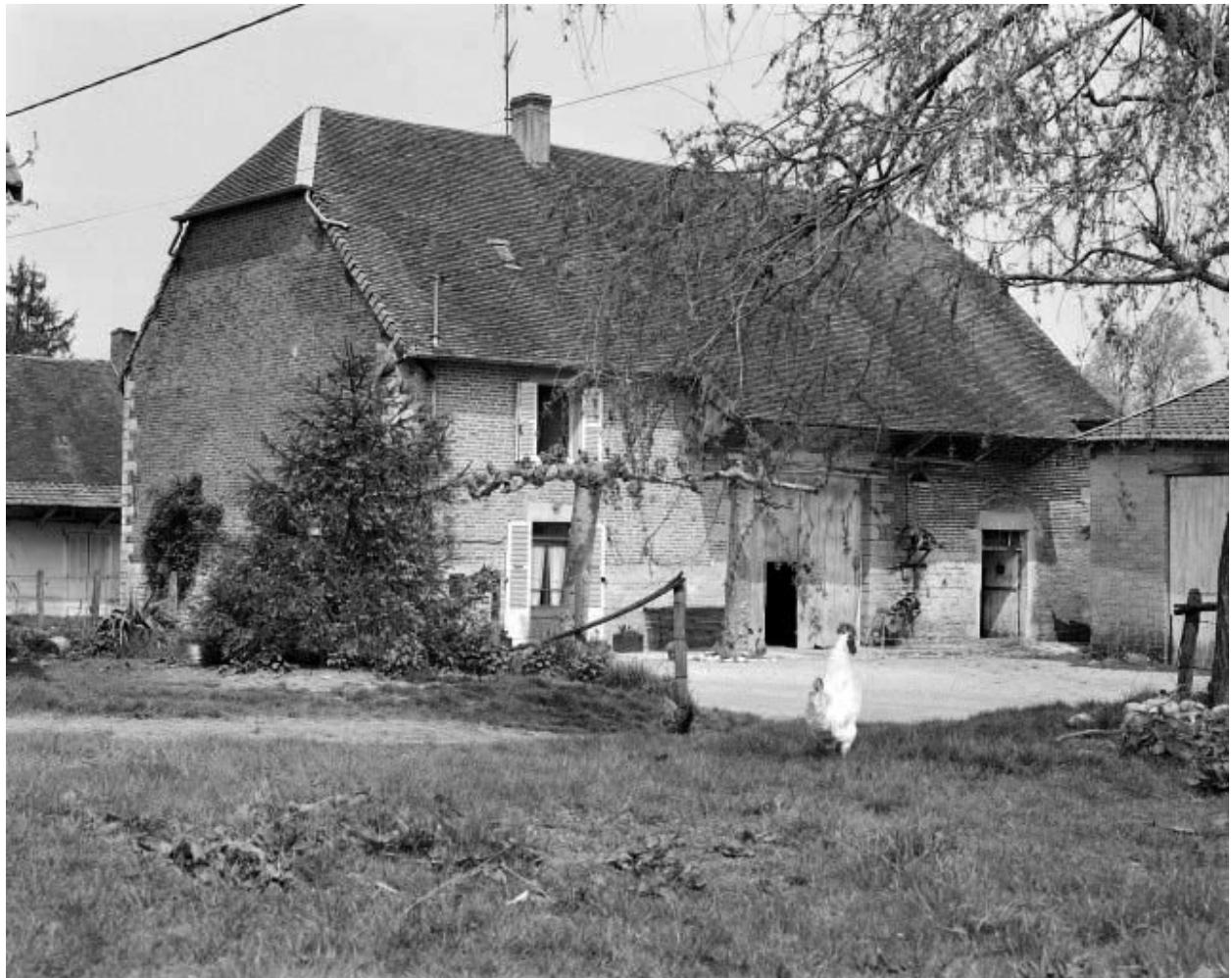
Façades antérieure et latérale droite.
