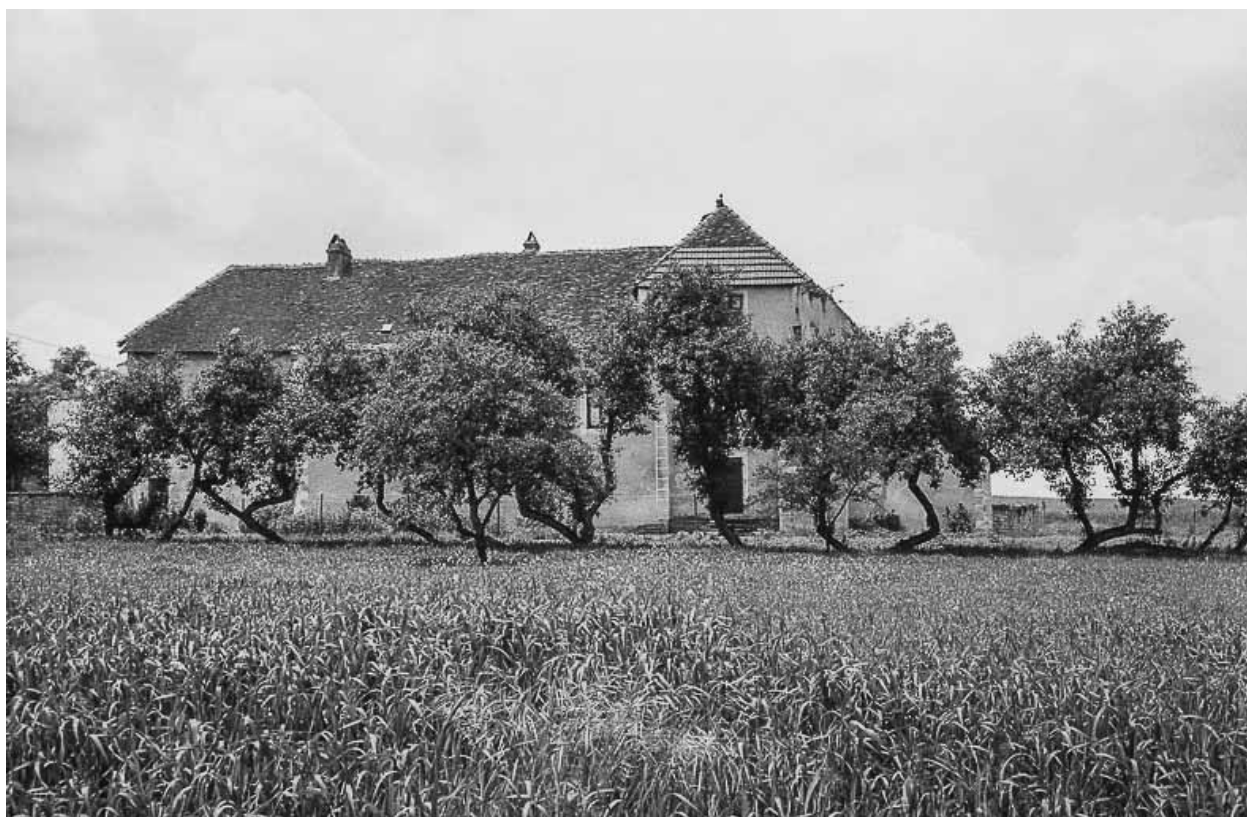
Façade postérieure du bâtiment.
