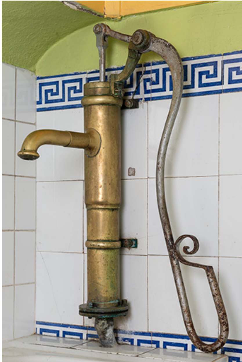
Rez-de-chaussée, cuisine, pompe à main.
