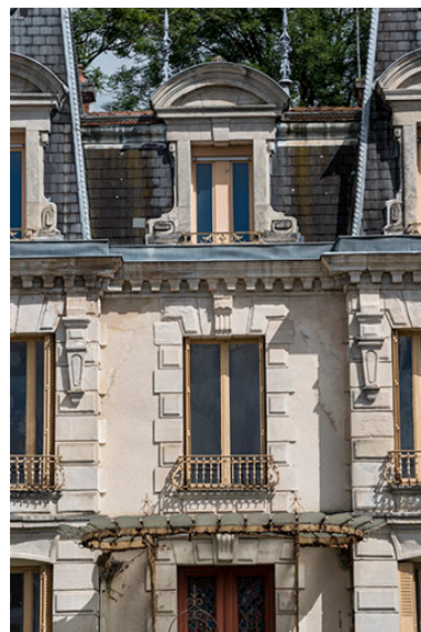
Détail de la travée centrale de la façade sud. Phot. Jérôme Mongreville IVR43_20187000468NUC4A
