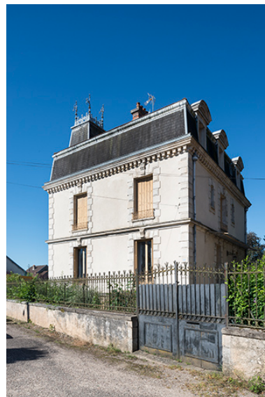
Façade latérale. Phot. Jérôme Mongreville IVR43_20187000472NUC4A
