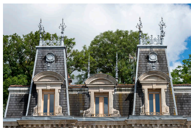
Toiture, côté sud. Phot. Jérôme Mongreville IVR43_20187000467NUC4A
