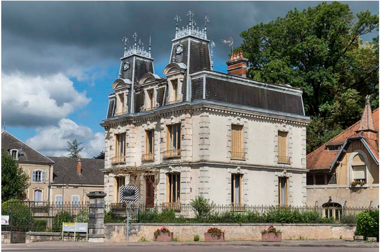
Vue d'ensemble de la maison, depuis l'est.
