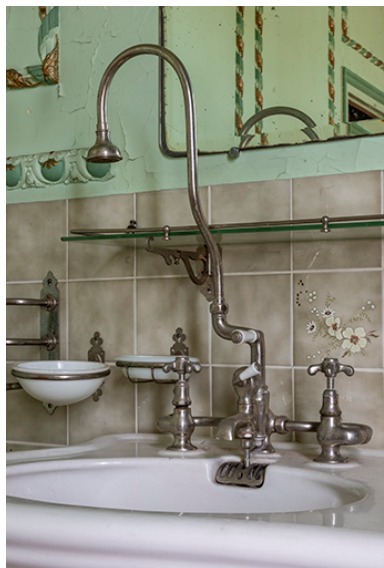
Premier étage, salle d'eau, robinets. Phot. Jérôme Mongreville IVR43_20187000630NUC4A
