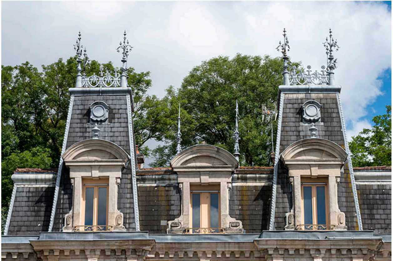
Toiture, côté sud.
