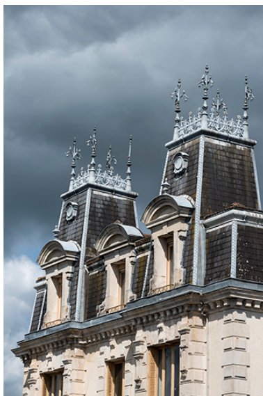
Toiture, côté sud. Phot. Jérôme Mongreville IVR43_20187000466NUC4A
