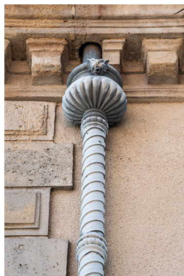
Descente d'eau en hélice avec cuvette godronnée. Phot. Jérôme Mongreville IVR43_20187000644NUC4A
