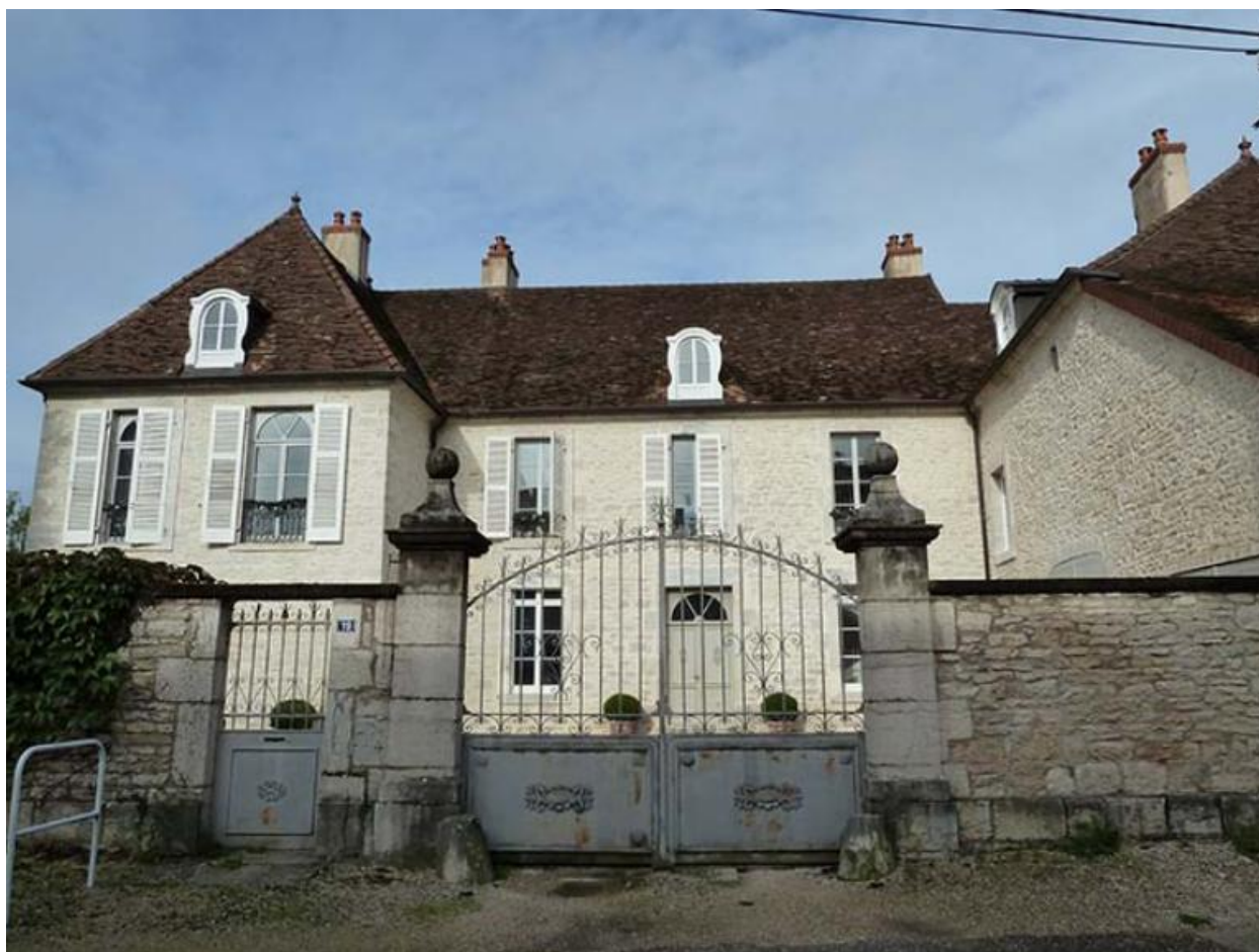
Vue générale sud
