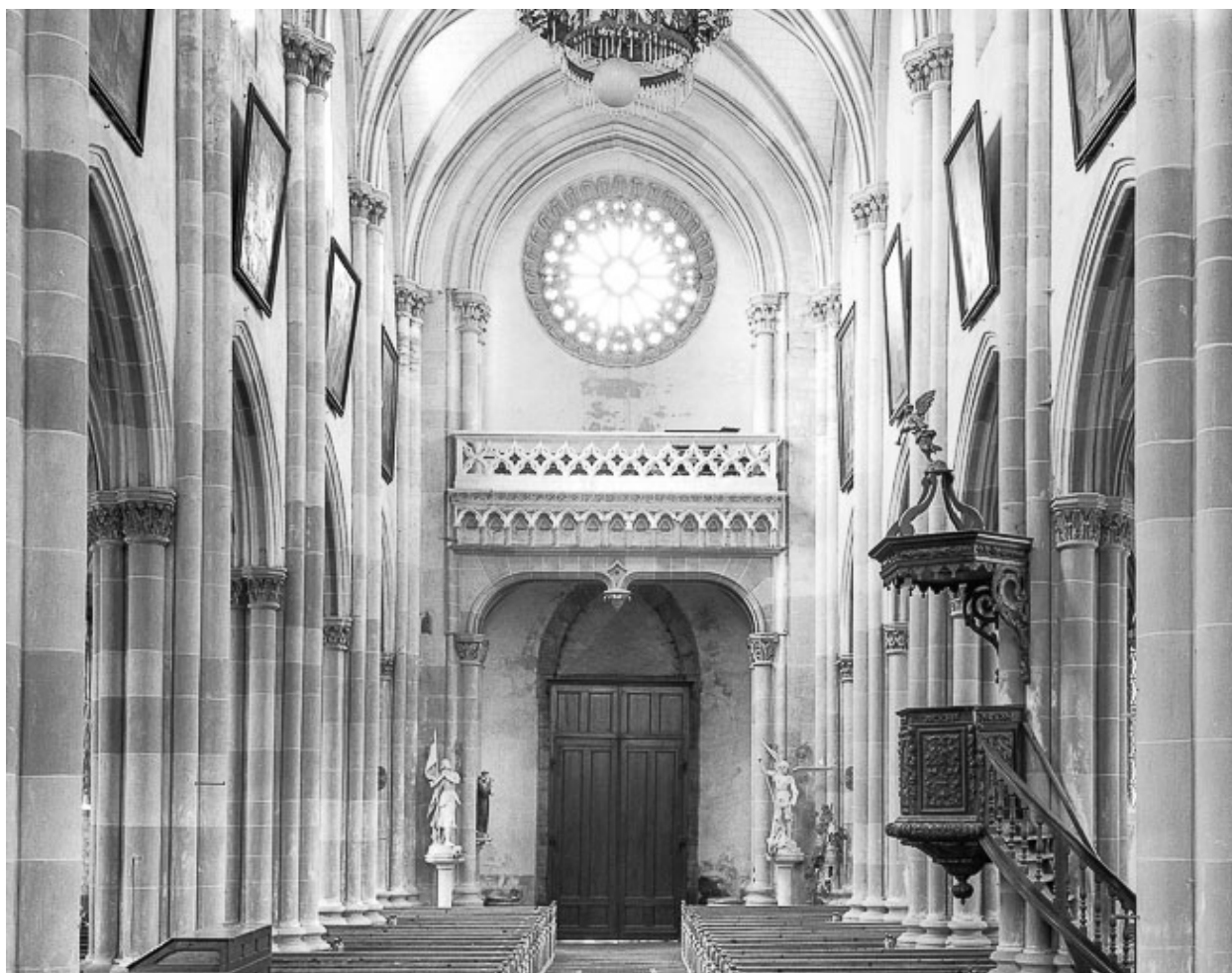
Nef vue depuis le chœur.
