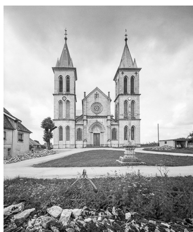
Façade antérieure. Phot. Yves Sancey IVR43_19752500289V
