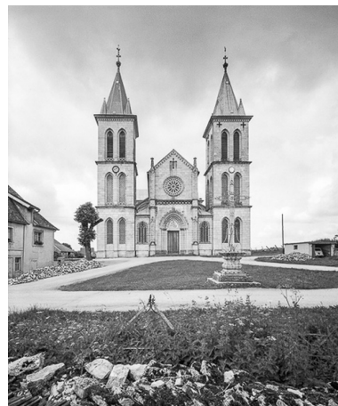
Façade antérieure. Phot. Yves Sancey IVR43_19752500289V
