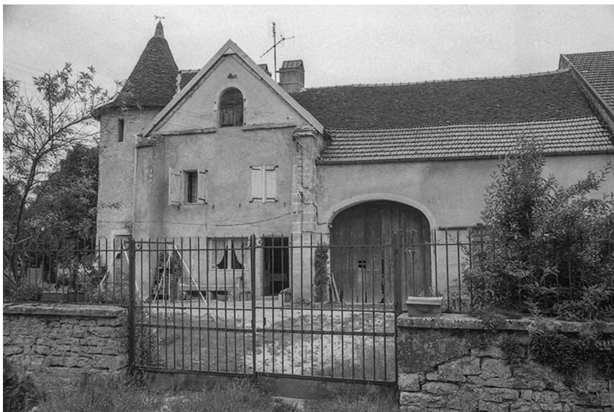
Façade antérieure depuis la cour.
