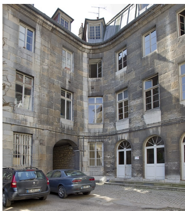
Logis principal : angle des façades sur cour.
