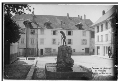
Vue d'ensemble [1re moitié 20e siècle].
