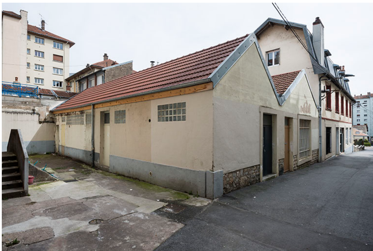
Vue depuis le nord de l'impasse Rambaud.
