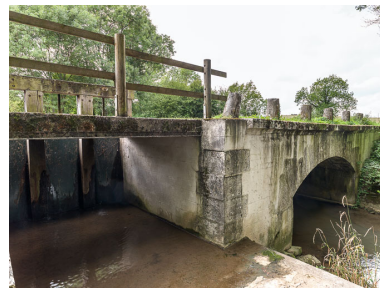
Au premier plan, le déversoir de fond qui évacue l'eau du canal dans le ruisseau d'Ardan. Au second plan, l'aqueduc qui permet au ruisseau de passer sous le canal. Phot. Pierre-Marie Barbe-Richaud IVR26_20175800328NUC2A
