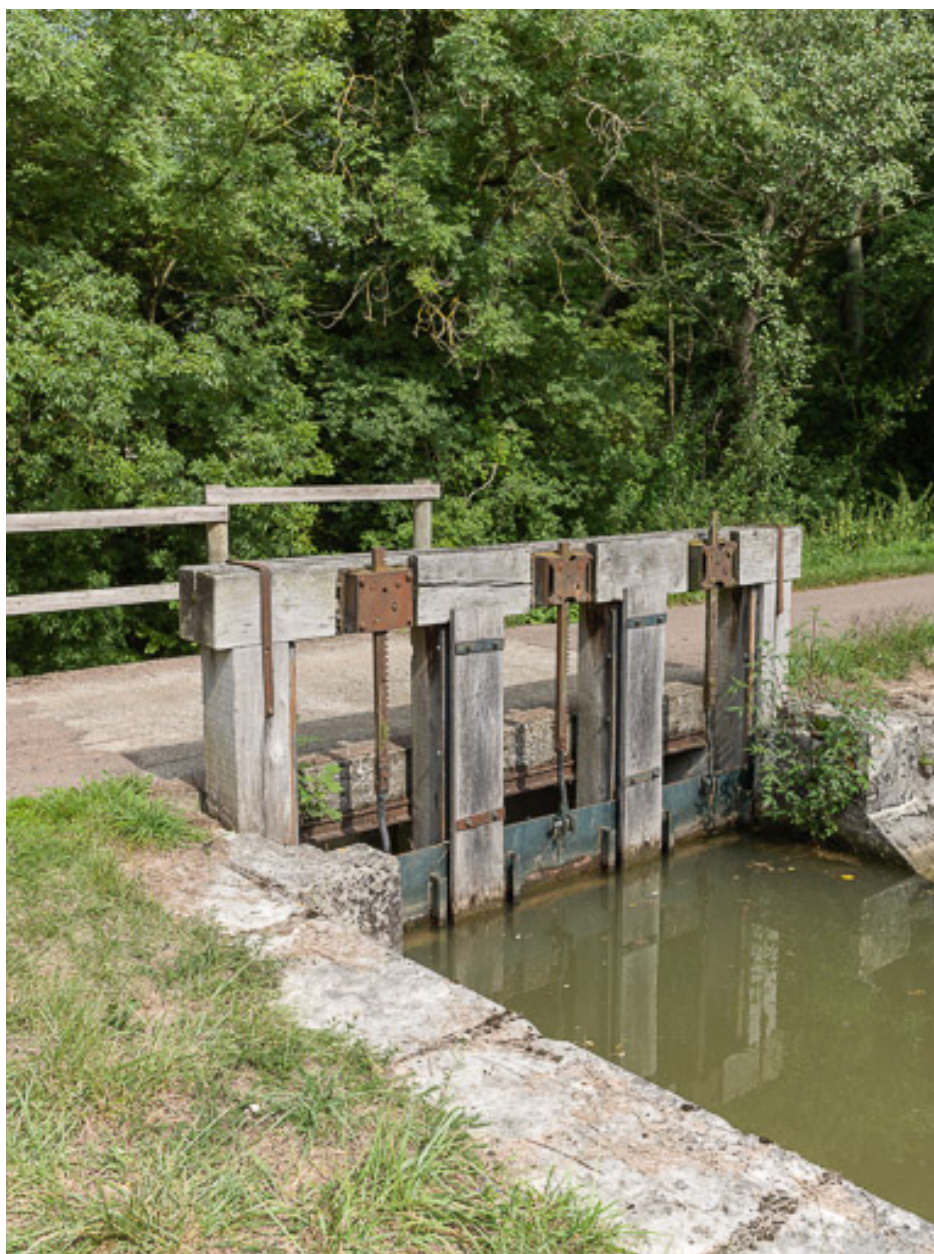
Le déversoir de fond, côté canal.
