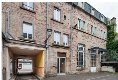
Façade sur la cour du corps côté rue. Phot. Jérôme Mongreville IVR43_20207000653NUC4A
