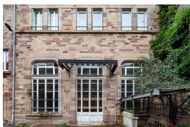
Façade sur la cour du corps côté rue, détail. Phot. Jérôme Mongreville IVR43_20207000652NUC4A
