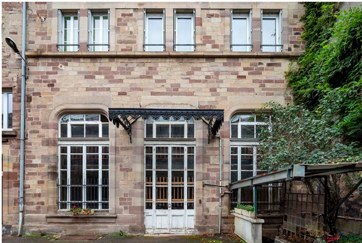
Façade sur la cour du corps côté rue, détail.
