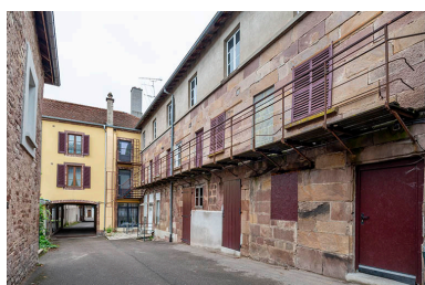
Passage entre les cours. Phot. Jérôme Mongreville IVR43_20207000654NUC4A
