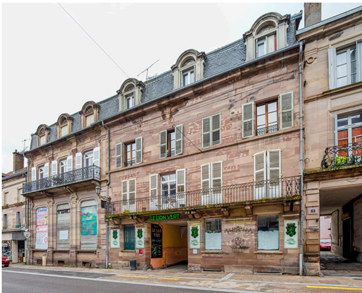
Vue d'ensemble depuis la rue.
