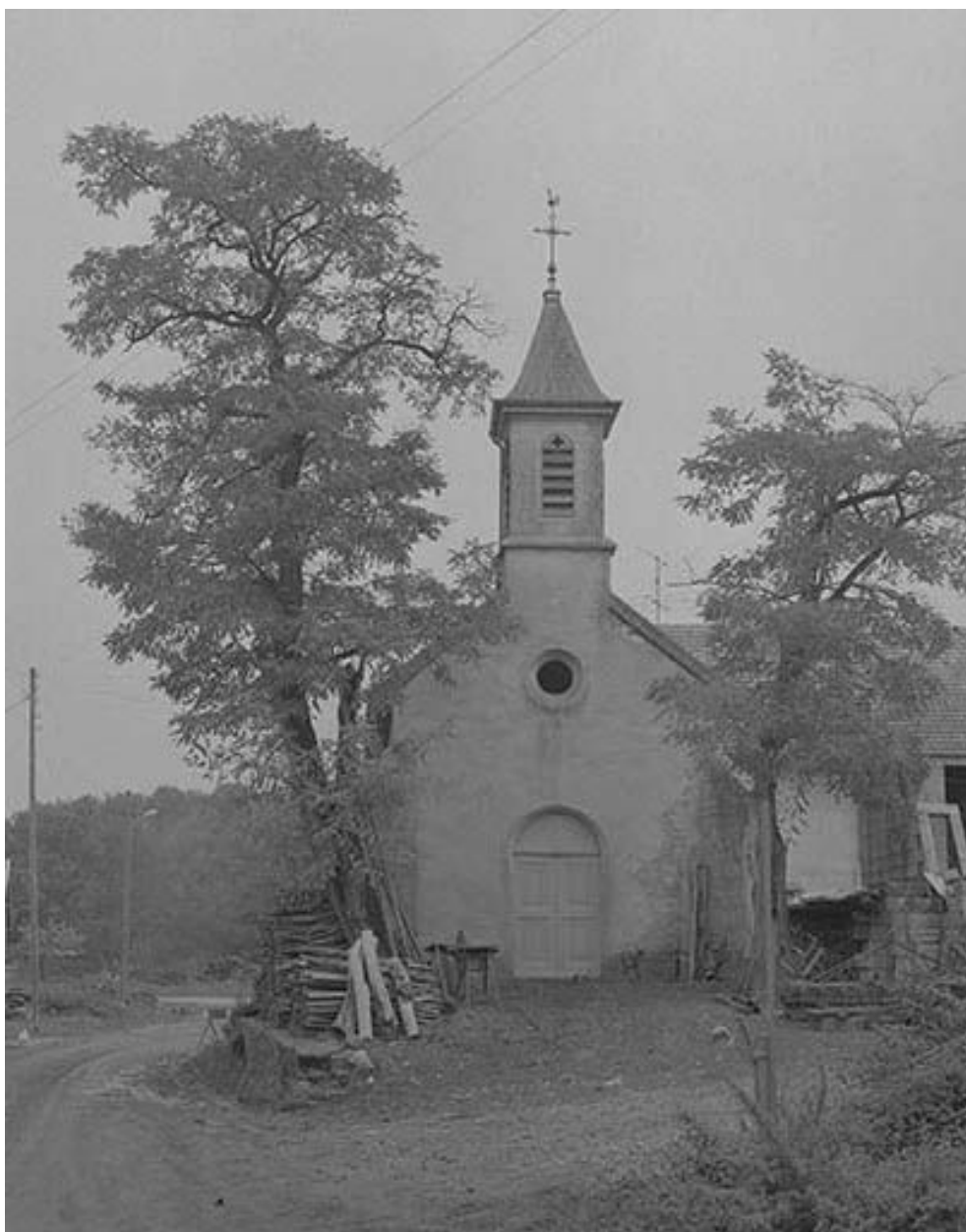
Extérieur : façade antérieure.
