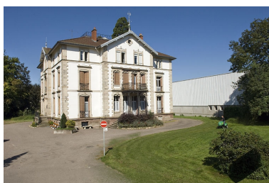
Logement patronal. Vue de trois quarts. Phot. Jérôme Mongreville IVR43_20067000850NUCA
