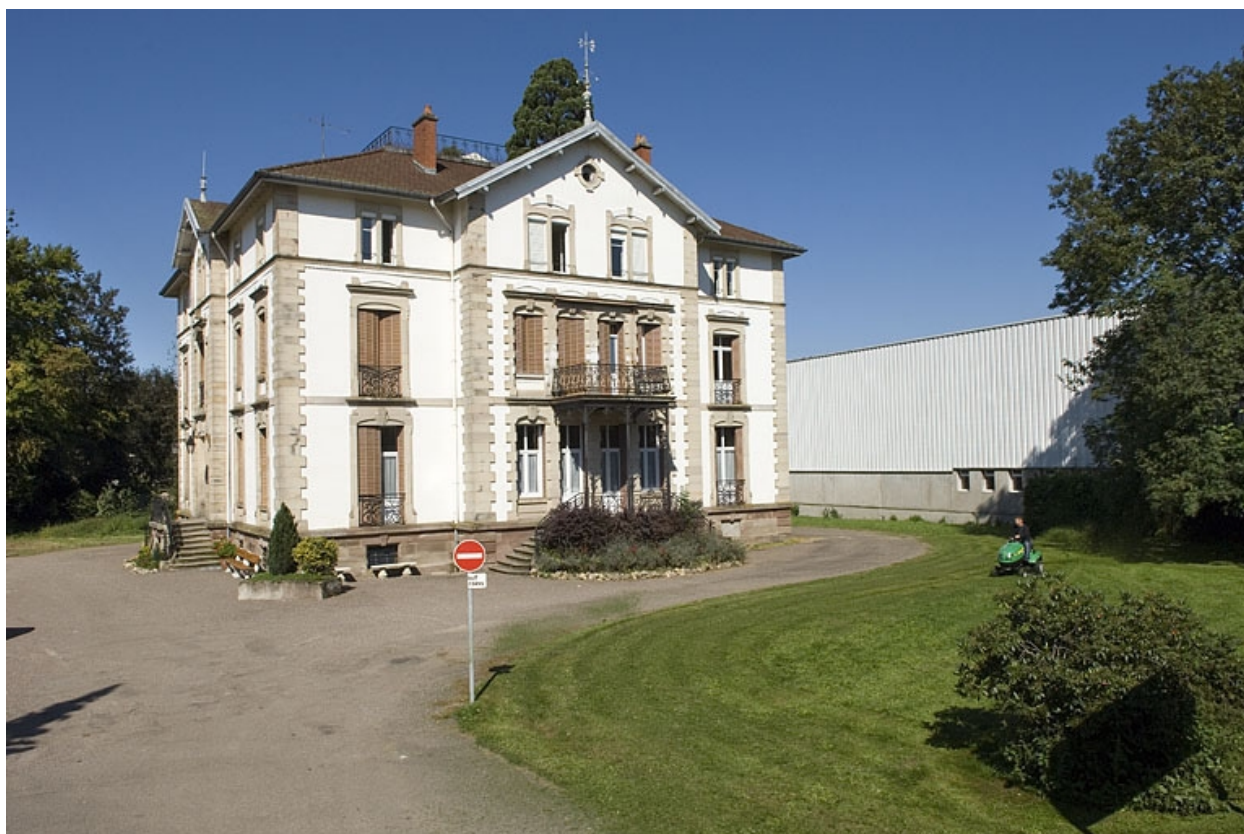
Logement patronal. Vue de trois quarts.
