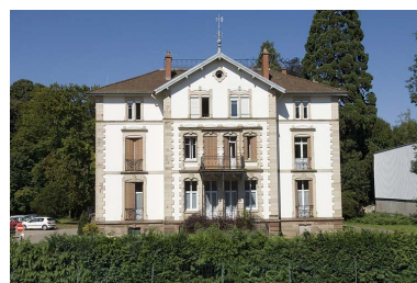
Logement patronal. Façade sud. Phot. Jérôme Mongreville IVR43_20067000848NUCA
