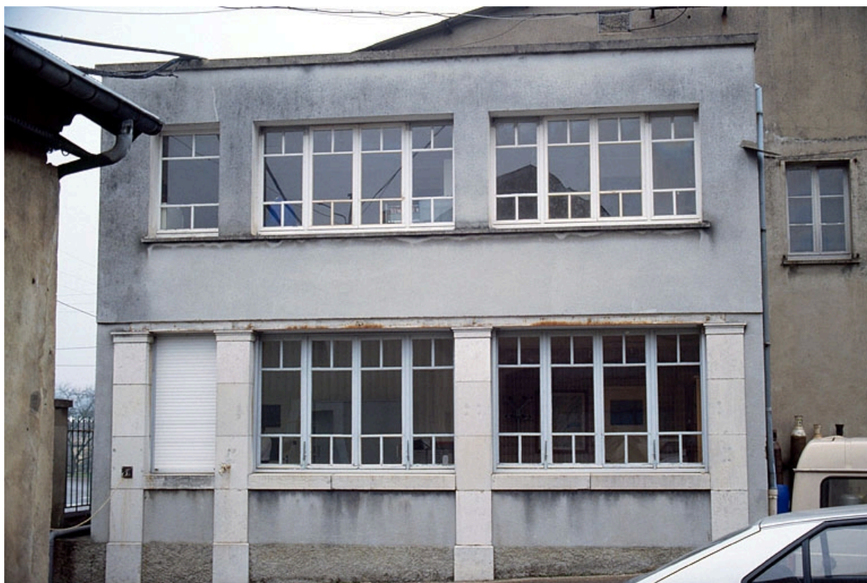
Façade antérieure du bureau depuis l'ouest.
