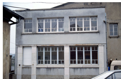
Façade antérieure du bureau depuis l'ouest. Phot. Laurent Poupard IVR43_19893900026ZA
