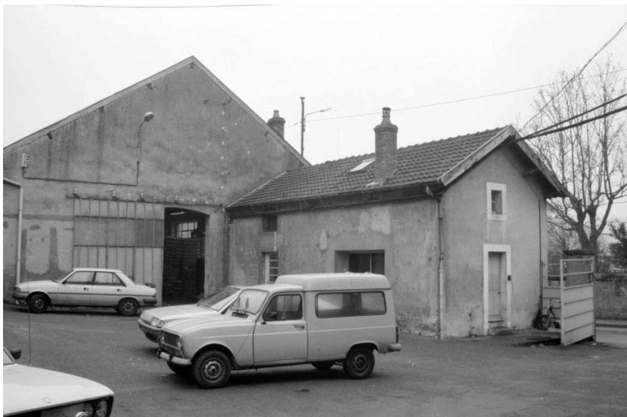
Entrée, cantine et entrepôt (8) vus de l'est.
