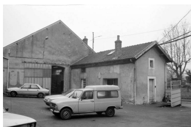
Entrée, cantine et entrepôt (8) vus de l'est. Phot. Laurent Poupard IVR43_19893900027Z
