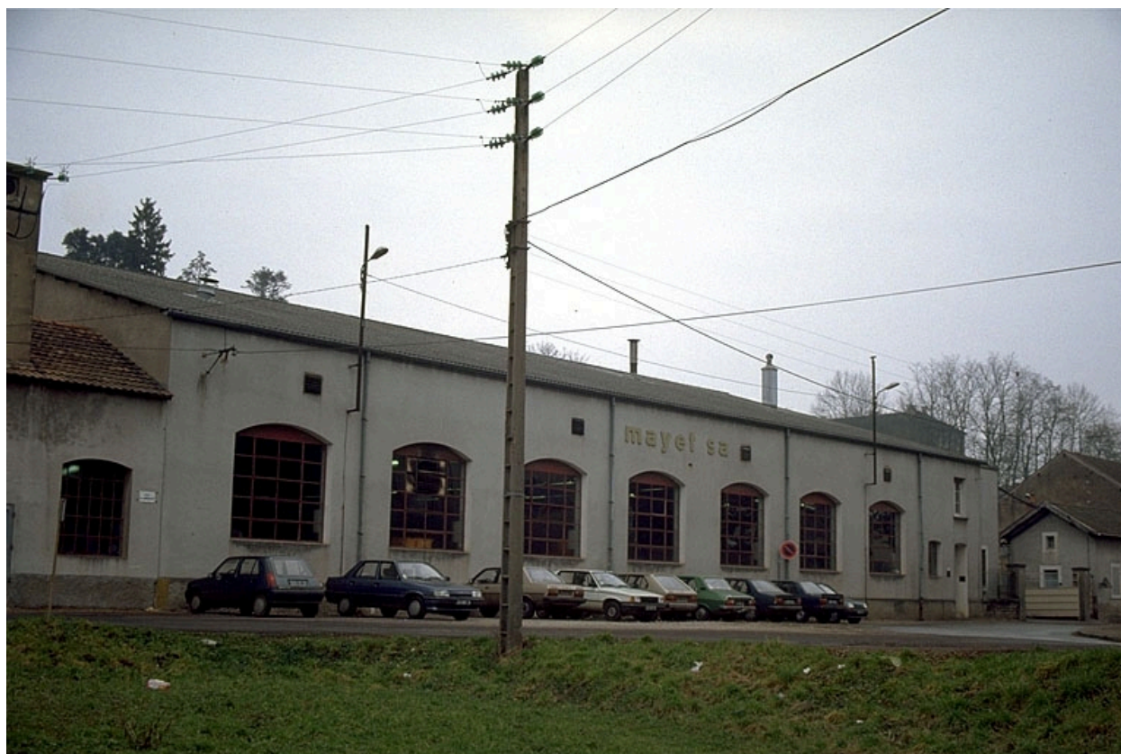
Façade antérieure de l'atelier de fabrication.
