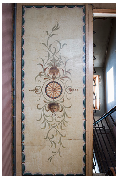
Plafond de la 5e volée.
