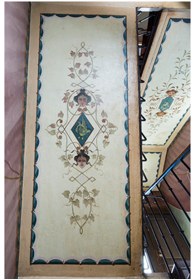
Plafond de la 3e volée. Phot. Sonia Dourlot IVR43_20182500727NUC4A
