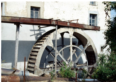
Roue en dessous. Phot. Laurent Poupard IVR43_19933900517ZA
