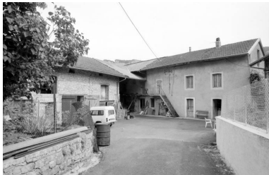
Vue d'ensemble, depuis l'entrée. Phot. Laurent Poupard IVR43_19933900512Z
