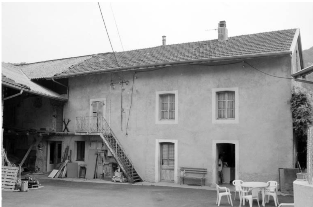
Façade antérieure du logement.
