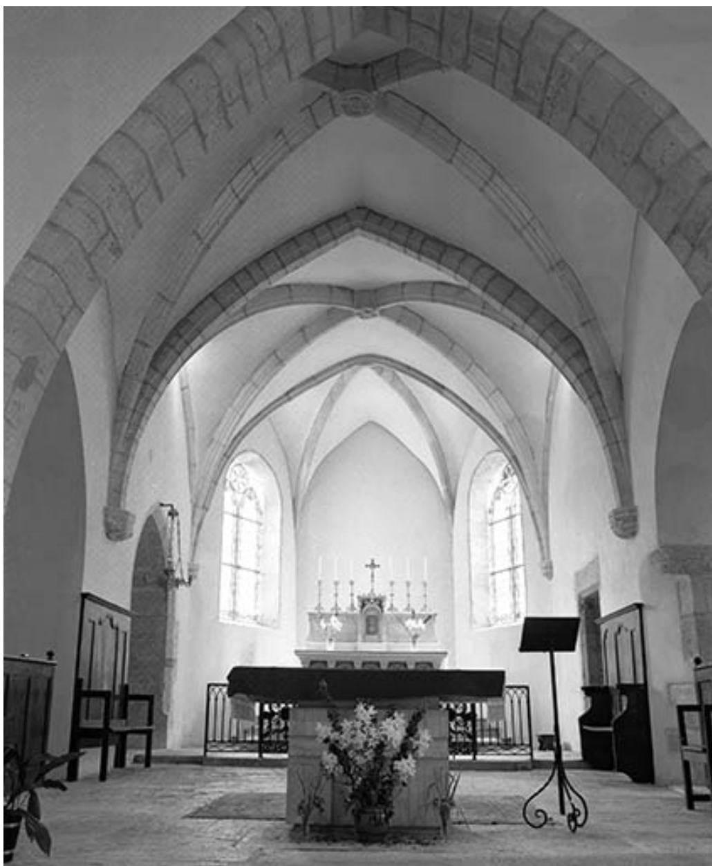
Eglise paroissiale Sainte-Madeleine : chœur vu depuis l'entrée.
