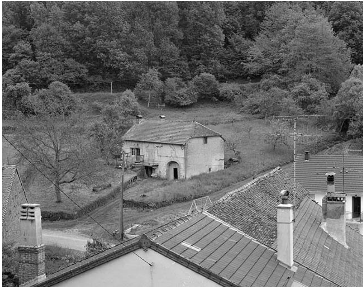
Ferme située rue Saint Vincent.
