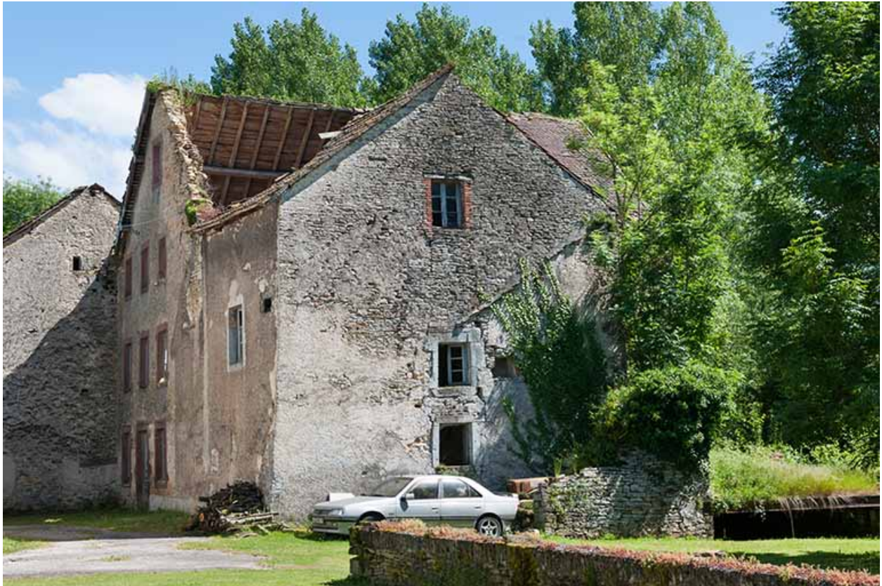
Le moulin depuis le nord-ouest.
