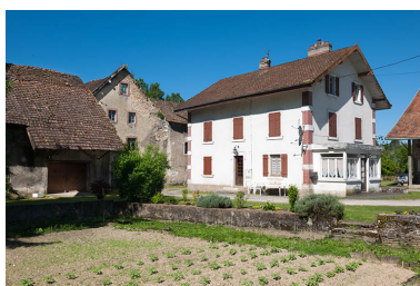
Moulin et logement vus depuis l'est. Phot. Jérôme Mongreville IVR43_20132500638NUC4A
