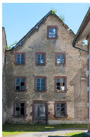
Pignon nord du moulin. Phot. Jérôme Mongreville IVR43_20132500645NUC4A
