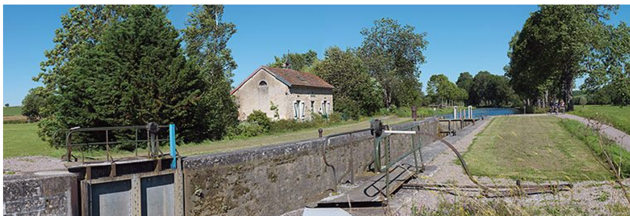
Vue d'ensemble du site pris d'aval.
