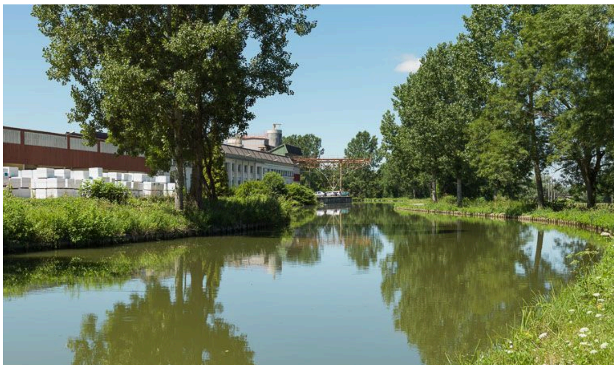
Vue d'ensemble de l'usine, rive gauche.
