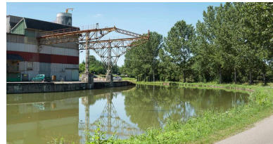
Le pont de chargement. Phot. Pierre-Marie Barbe-Richaud IVR26_20137100529NUC4AQ
