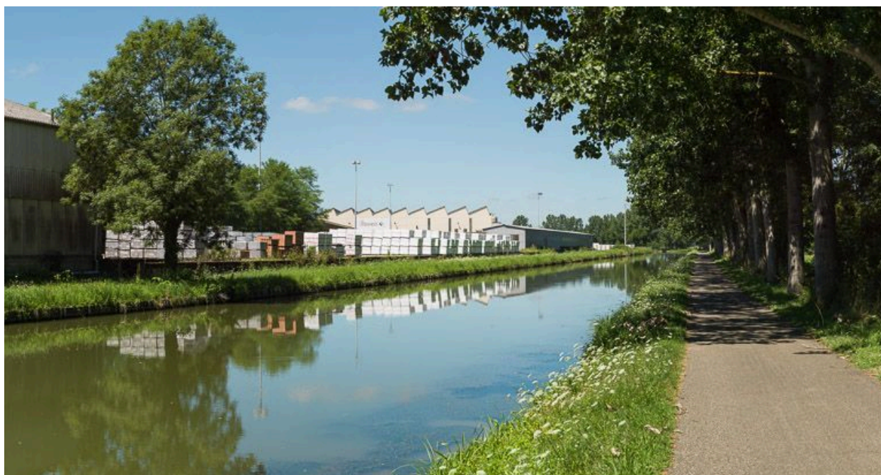
Vue d'ensemble d'amont.
