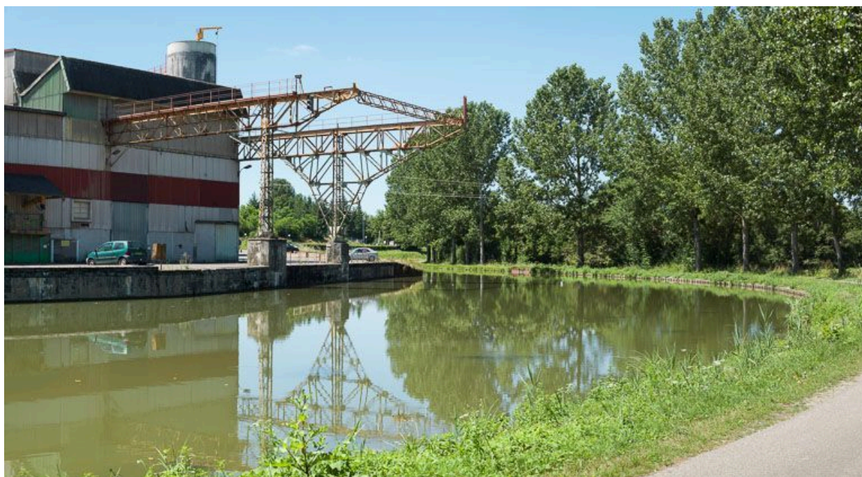
Le pont de chargement.
