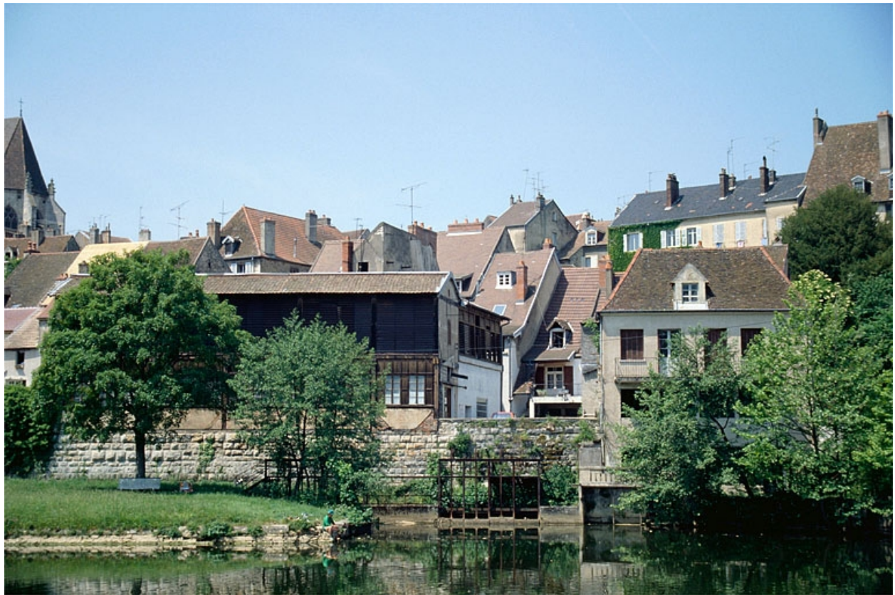
Pièce de séchage, depuis l'est.
