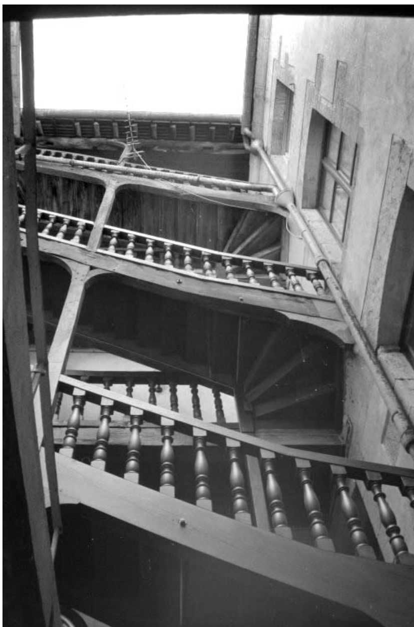
Escalier de distribution extérieur (D).
