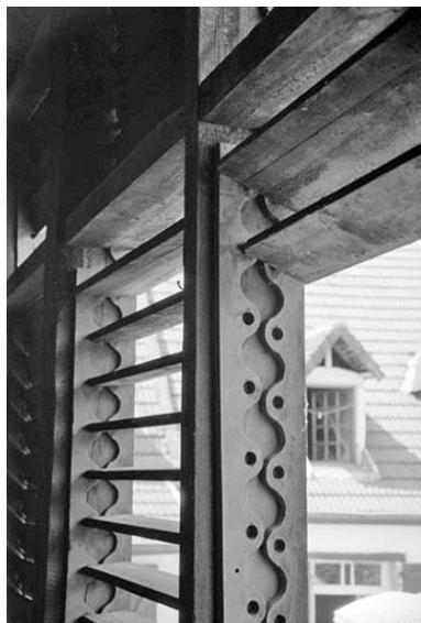
Pièce de séchage, étage de comble : détail du système de fermeture à lamelles mobiles. Phot. Laurent Poupard IVR43_19893900108Z
