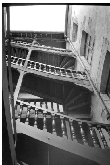
Escalier de distribution extérieur (D). Phot. Laurent Poupard IVR43_19893900111Z
