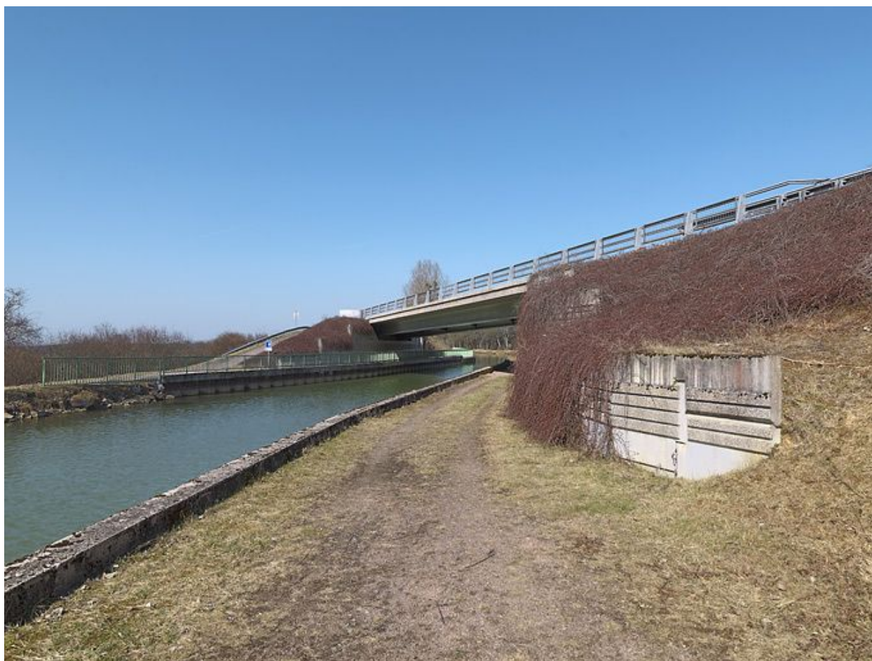
Vue d'ensemble du pont.
