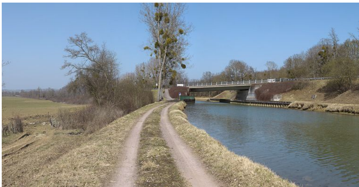
Vue d'ensemble du pont.
