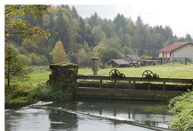
Vannage de prise d'eau. Phot. Jérôme Mongreville IVR43_20082501047NUC2A
