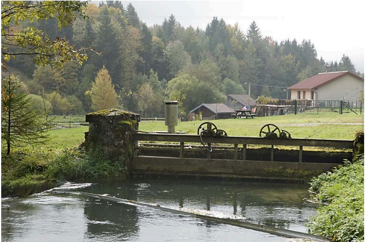
Vannage de prise d'eau.
