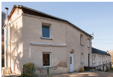
Façade nord du logement et de l'atelier. Phot. Jérôme Mongreville IVR43_20152501002NUC4A
