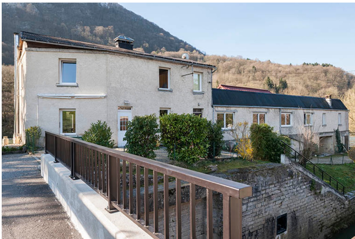
Logement et atelier de fabrication depuis l'écluse.
