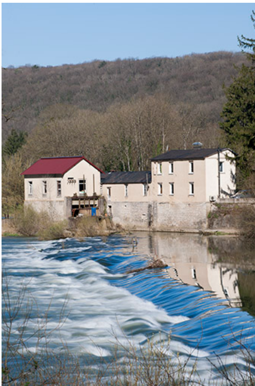
Vue depuis la rive gauche du barrage.
