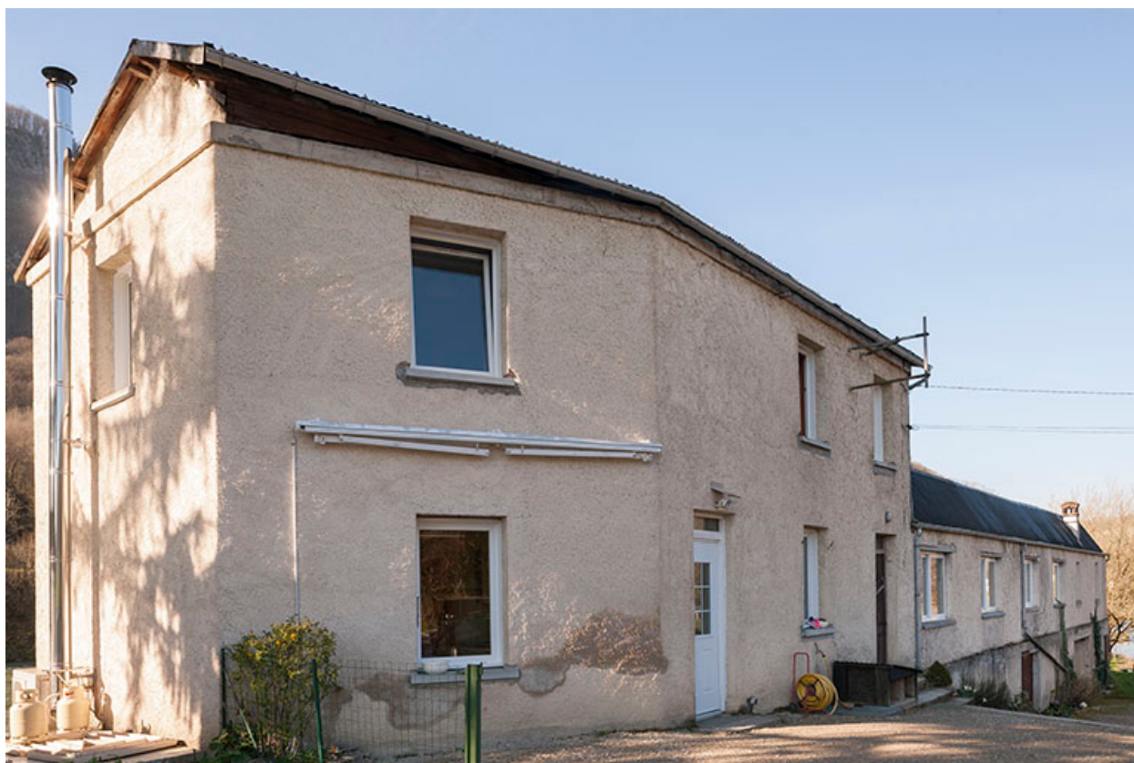
Façade nord du logement et de l'atelier.
