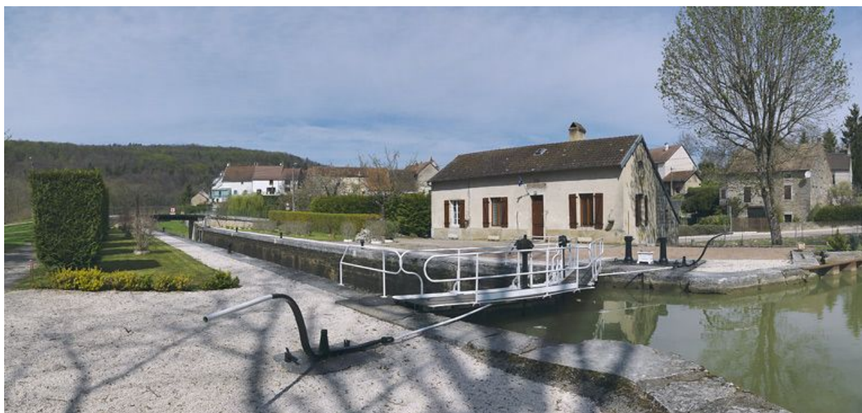
Vue d'ensemble de l'amont du site d'écluse.
