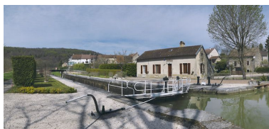
Vue d'ensemble de l'amont du site d'écluse. Phot. Thierry Kuntz IVR26_20122102429NUC4AQ
