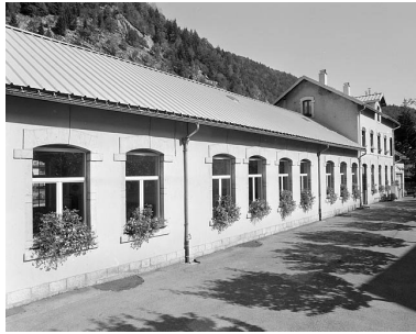
Corps de bâtiment en rez-de- chaussée, de trois quarts gauche. Phot. Yves Sancey IVR43_20033900375X
