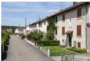
Habitations vues de trois quarts. Façade antérieure. Phot. Jérôme Mongreville IVR43_20112502180NUC4A
