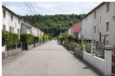
Vue d'ensemble d'une rue. Phot. Jérôme Mongreville IVR43_20112502184NUC4A
