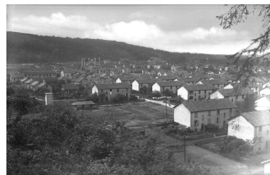
La cité du Maroc. Photogr., s.d. [vers 1930]. Phot. Raphaël Favereaux, Autr. Mayer (photographe) IVR43_20122501506NUC2
