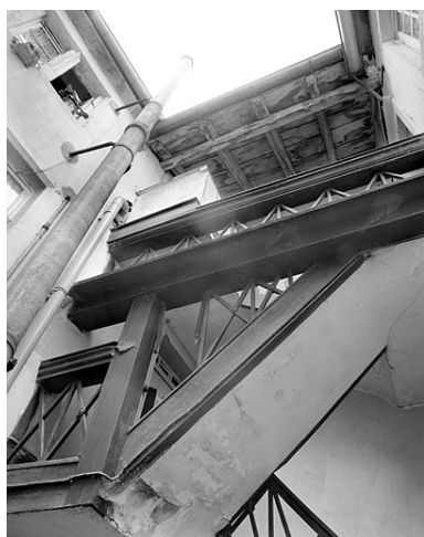
Escalier/galerie. Phot. Jérôme Mongreville IVR43_19872500961X
