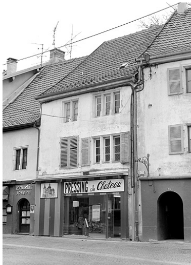
Façade sur rue. Phot. Jérôme Mongreville IVR43_19882500044X
