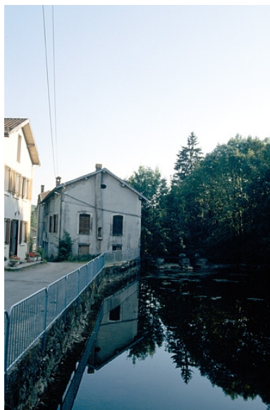
Logement vu du nord. Phot. Laurent Poupard IVR43_19913901246ZA
