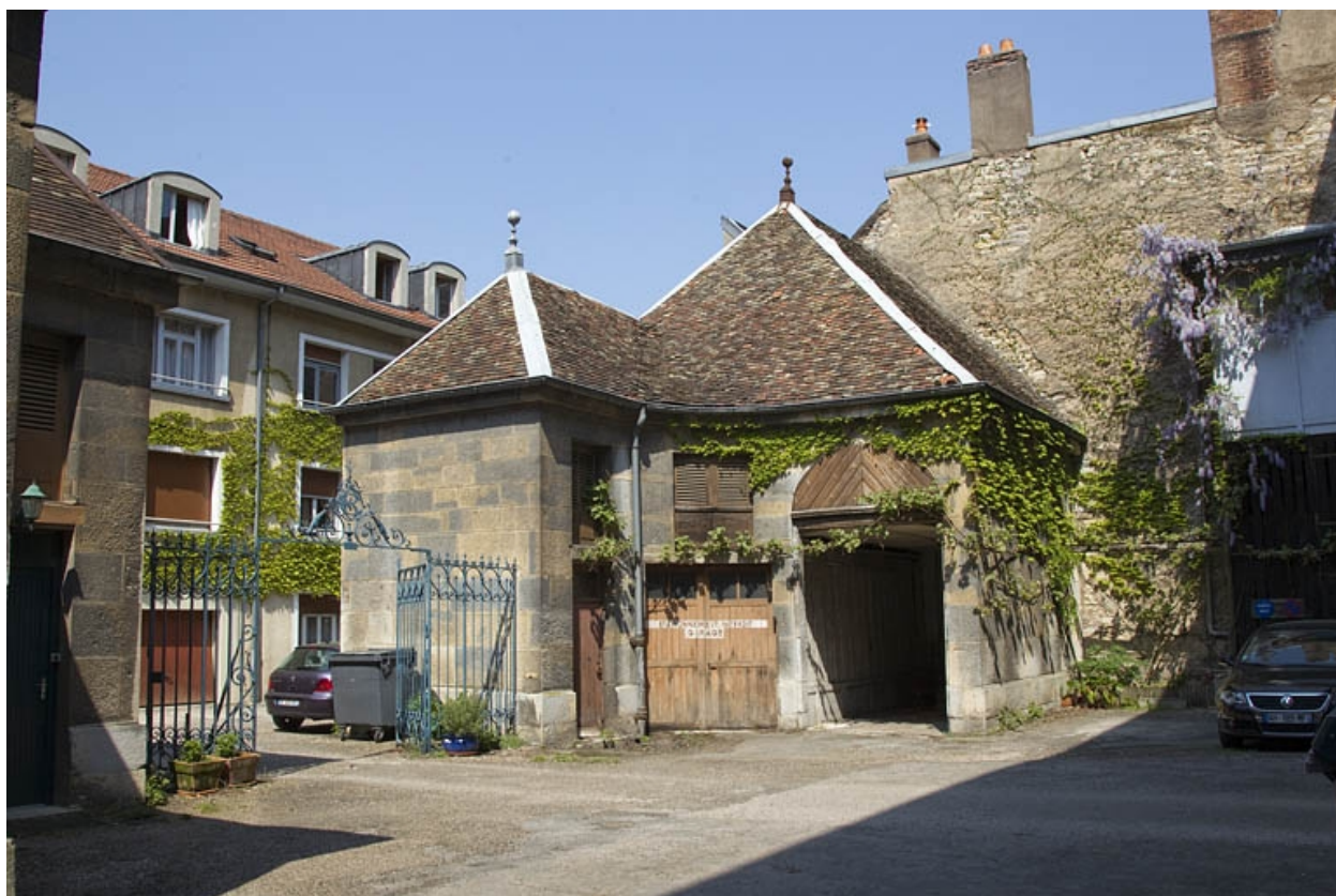
Détail de la remise droite.
