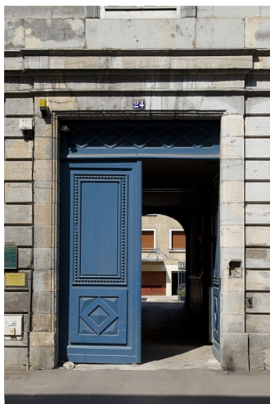
Détail du portail d'entrée.
