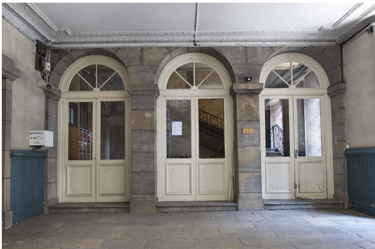
Vue de l'entrée de l'escalier, de face.
