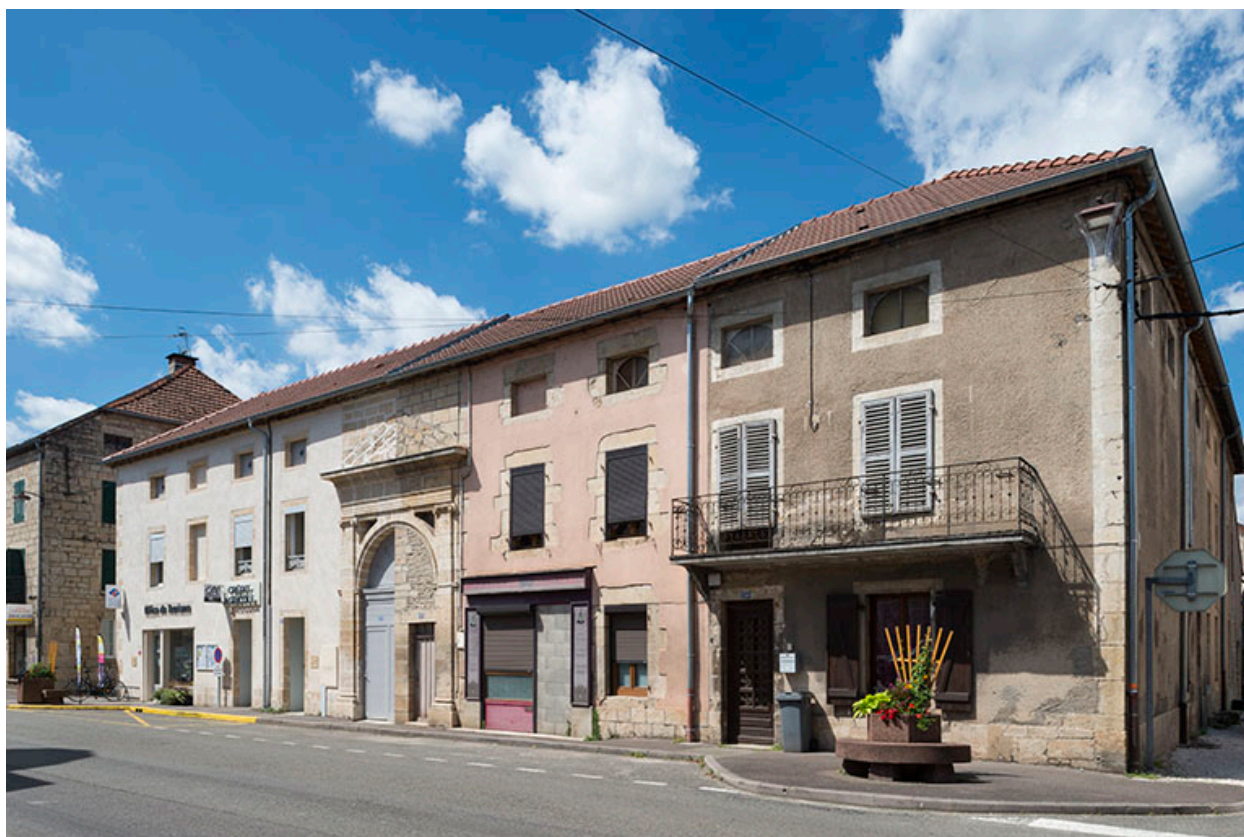
Élévation extérieure sur la rue Armand-Paulmard et la rue des Fours.
