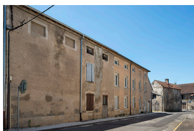
Élévation extérieure sur la rue des Fours. Phot. Jérôme Mongreville IVR43_20187000426NUC4A
