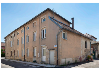
Élévation extérieure sur la rue des Fours. Phot. Jérôme Mongreville IVR43_20187000425NUC4A
