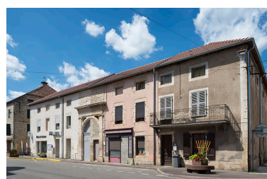
Élévation extérieure sur la rue Armand-Paulmard et la rue des Fours. Phot. Jérôme Mongreville
