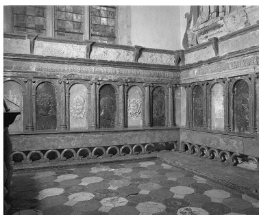
Façades sud et ouest de la chapelle.
