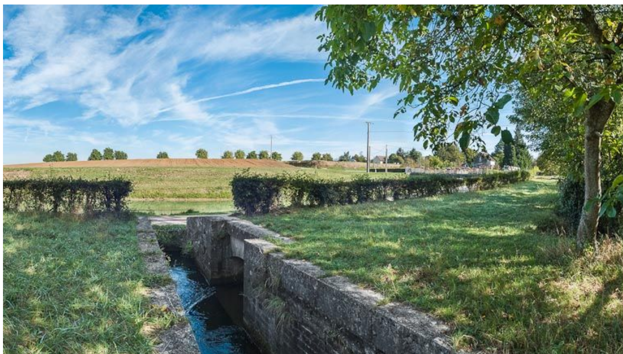
Détail de maçonnerie de la rigole.
