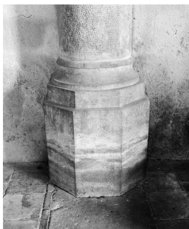
Base de la colonne antérieure droite de la nef. Phot. Michel Thierry IVR26_19775800092X
