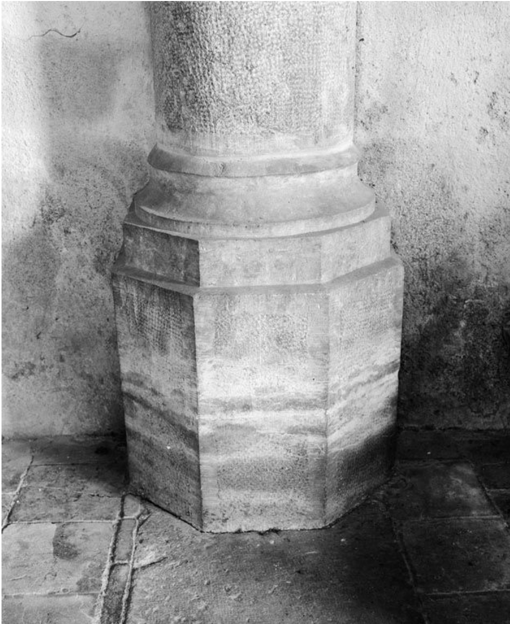
Base de la colonne antérieure droite de la nef.
