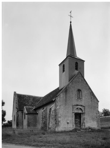
Vue d'ensemble, de trois-quarts. Phot. Jean-Luc Duthu IVR26_19775800082V
