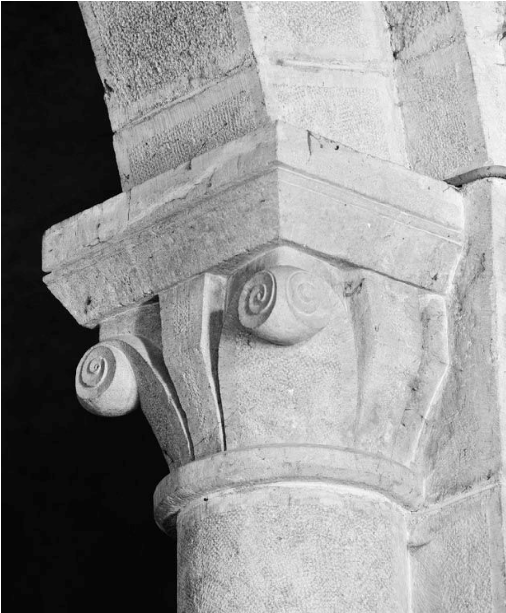
Détail du chapiteau de la troisième colonne de droite de la nef.
