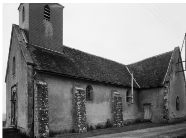
Élévation latérale gauche. Phot. Jean-Luc Duthu IVR26_19775800086V
