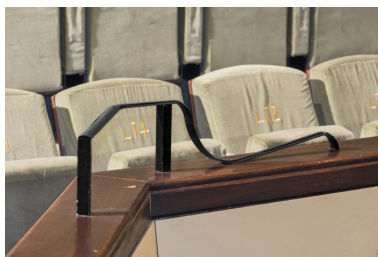
Salle, balcon : ferronnerie sur le garde-corps. Phot. Pierre-Marie Barbe-Richaud IVR26_20238900972NUC4A
