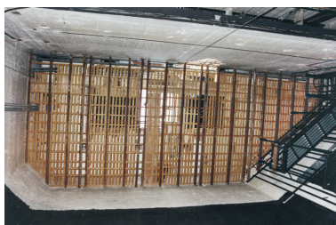
[Gril en cours de restauration, vu du dessous]. S.d. [1997-1998].
