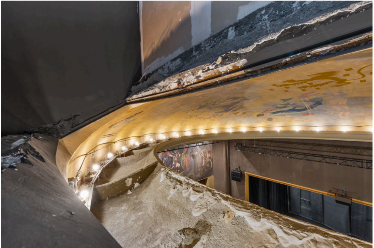
Intrados de la coupole et intérieur de la corniche, depuis la régie.
