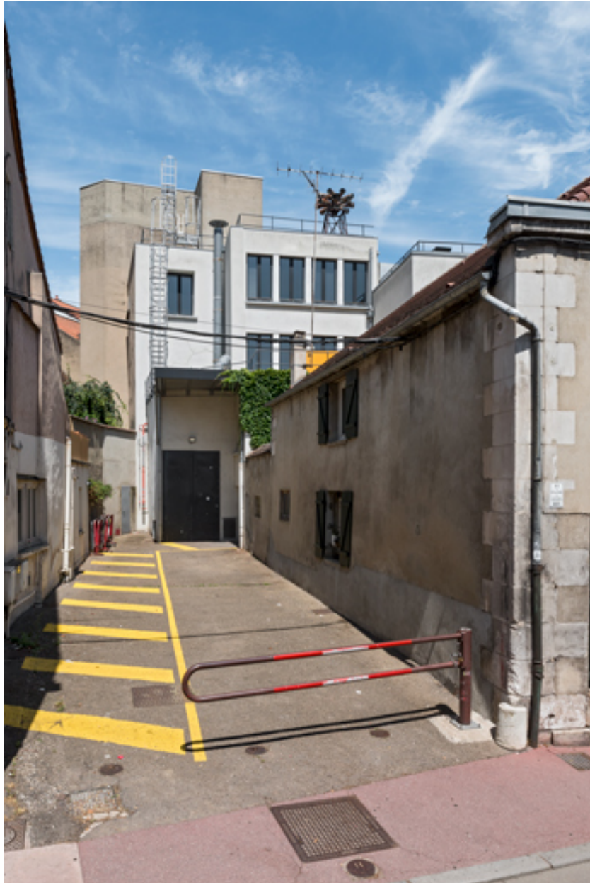
Voie d'accès pour les décors, au sud.
