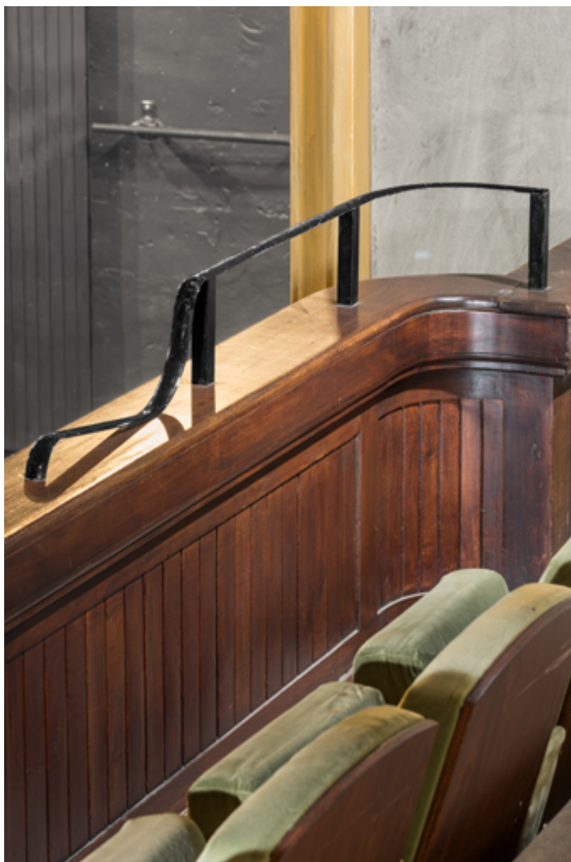
Salle, balcon : ferronnerie sur le garde-corps, côté cour.
