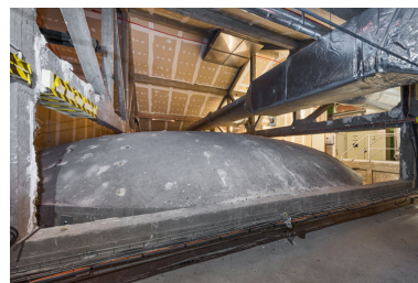
Extrados de la coupole et charpente en béton armé. Phot. Pierre-Marie Barbe-Richaud IVR26_20238900975NUC4A
