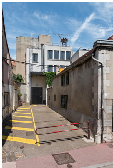
Voie d'accès pour les décors, au sud. Phot. Pierre-Marie Barbe-Richaud IVR26_20238900963NUC4A
