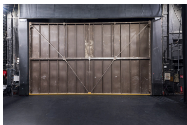
Scène : rideau coupe-feu baissé. Phot. Pierre-Marie Barbe-Richaud IVR26_20238900987NUC4A
