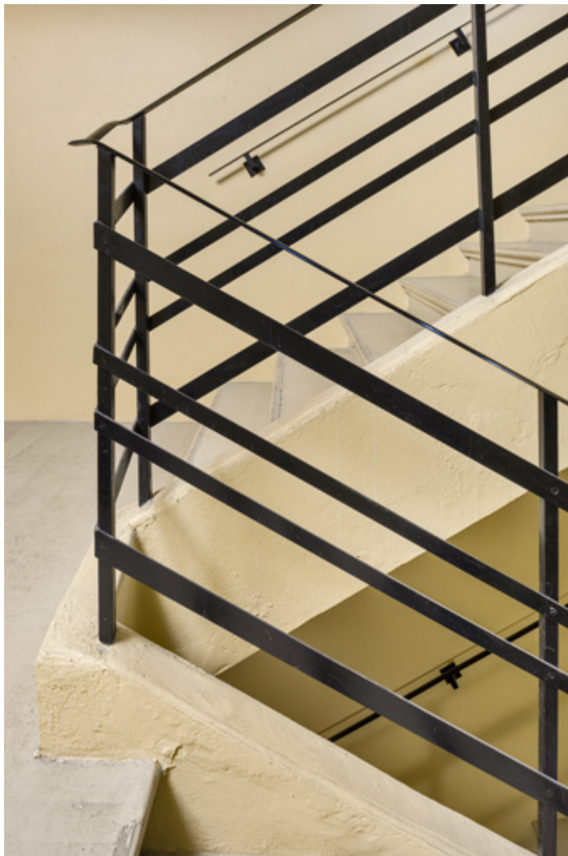
Aile nord : détail de la rampe de l'escalier du personnel, au 1er palier.
