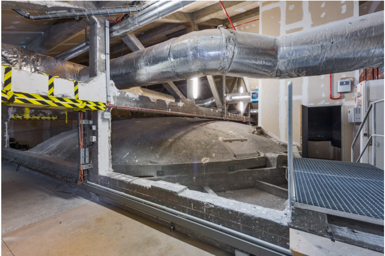
Coupole et charpente en béton armé. La régie est au fond à droite.
