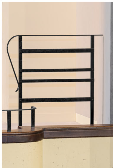
Salle, balcon : ferronnerie sur le garde-corps, côté jardin. Phot. Pierre-Marie Barbe-Richaud IVR26_20238901003NUC4A
