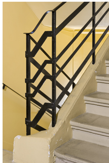
Aile nord : rampe de l'escalier du personnel, au 1er palier. Phot. Pierre-Marie Barbe-Richaud IVR26_20238901010NUC4A
