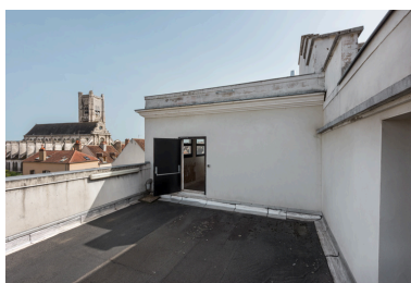
Terrasse sur l'aile sud et ancienne salle d'escrime. Phot. Pierre-Marie Barbe-Richaud IVR26_20238900980NUC4A
