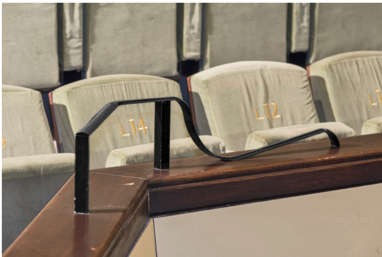
Salle, balcon : ferronnerie sur le garde-corps.
