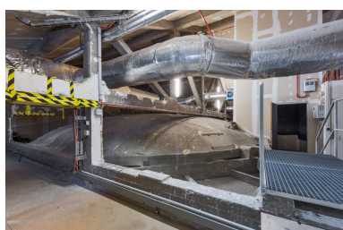
Coupole et charpente en béton armé. La régie est au fond à droite. Phot. Pierre-Marie Barbe-Richaud IVR26_20238900974NUC4A
