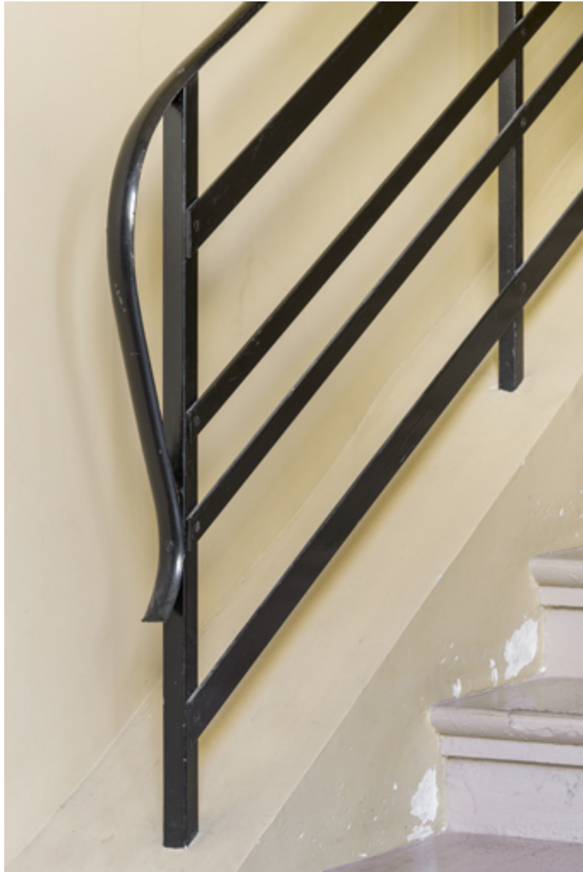
Aile nord : départ de rampe de l'escalier du personnel.
