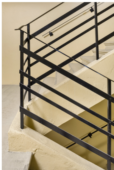
Aile nord : détail de la rampe de l'escalier du personnel, au 1er palier. Phot. Pierre-Marie Barbe-Richaud IVR26_20238901008NUC4A
