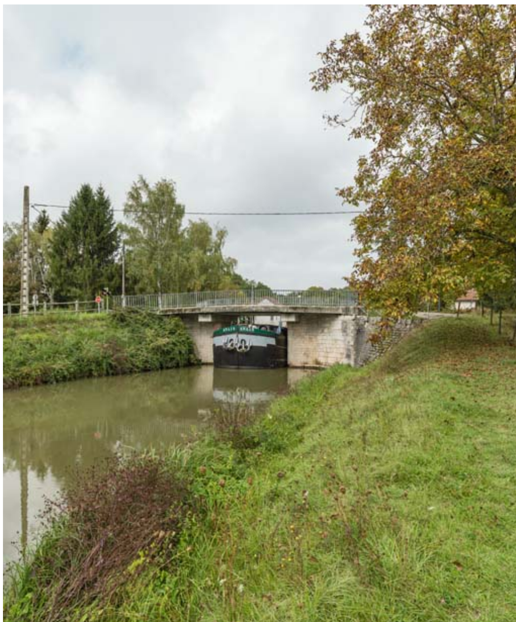
Vue d'ensemble du pont.
