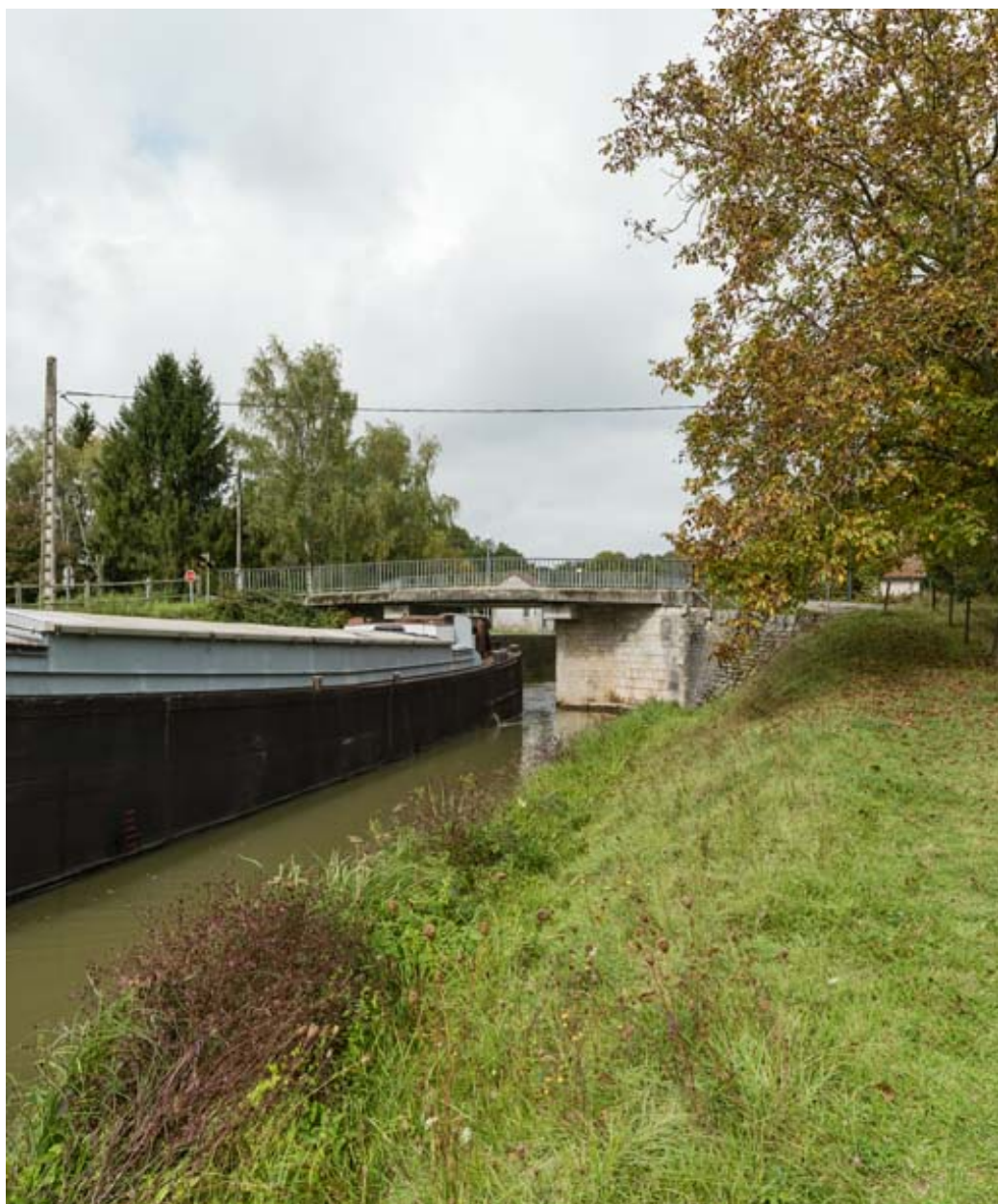
Vue d'ensemble du pont.
