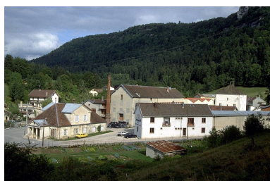
Entrée de l'usine.
