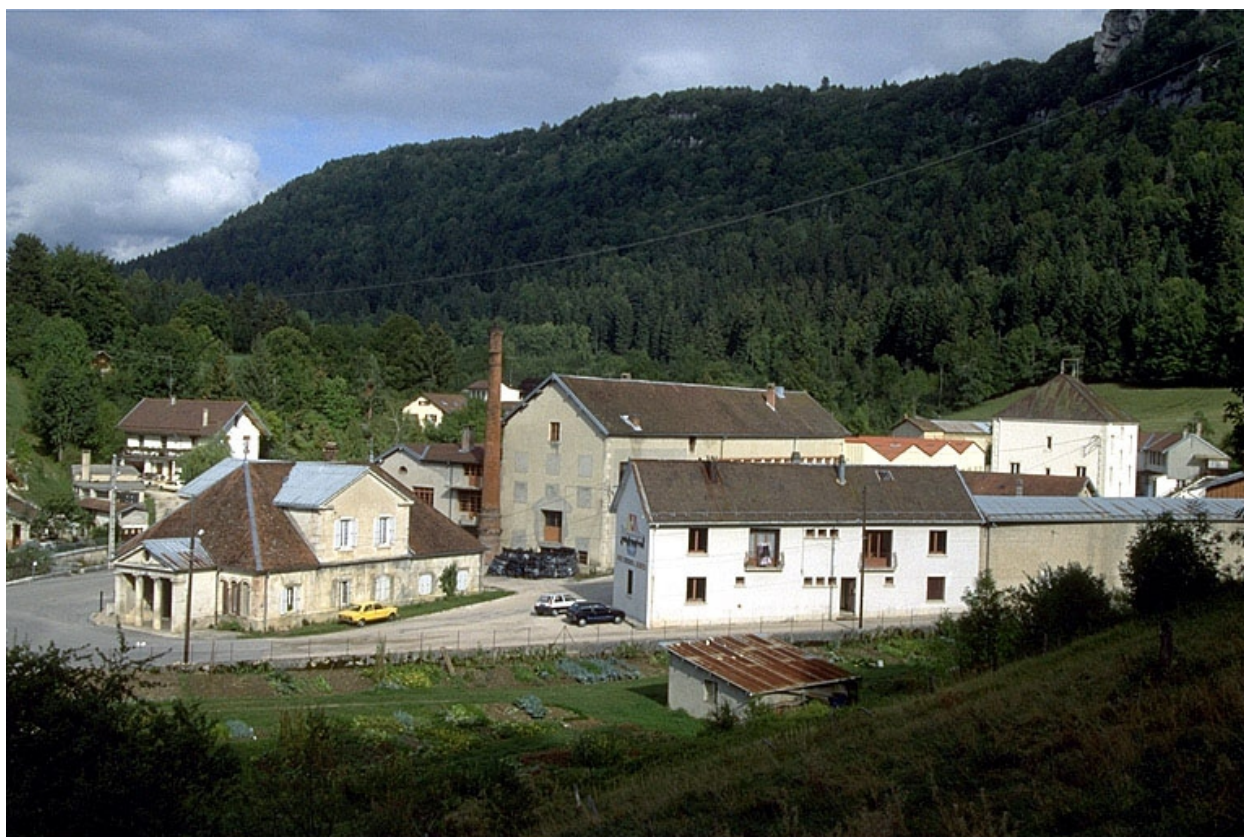
Entrée de l'usine.
