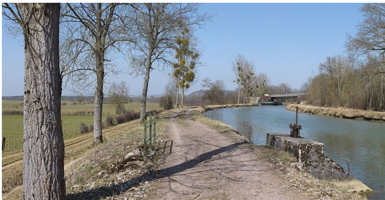
Le déversoir rive gauche dans son environnement.
