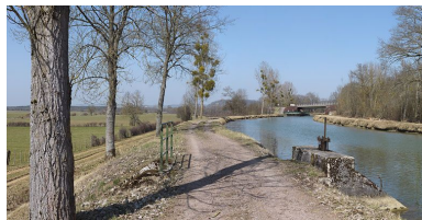
Le déversoir rive gauche dans son environnement.
