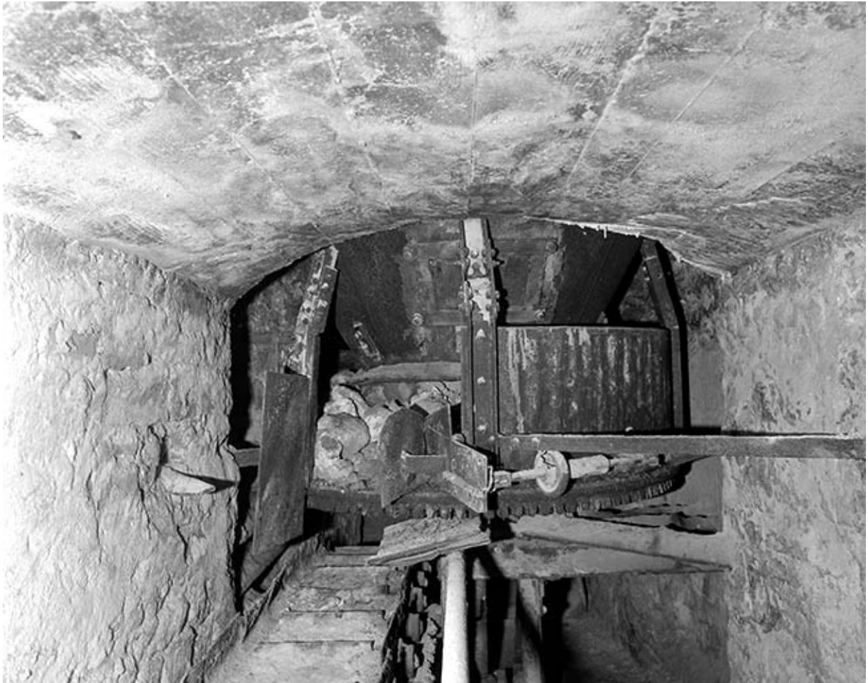
Extracteur d'un four à surcuit.
