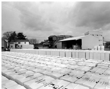
Vue d'ensemble depuis l'est (partie nord). Phot. Yves Sancey IVR43_19973900398X
