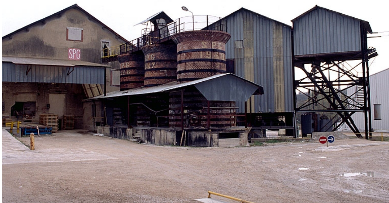
L'ancienne usine depuis le sud. De gauche à droite : bâtiment des fours, anciens fours à surcuit, broyeur et poste de chargement.
