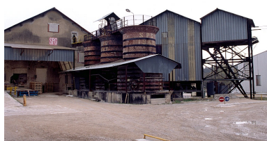
L'ancienne usine depuis le sud. De gauche à droite : bâtiment des fours, anciens fours à surcuit, broyeur et poste de chargement. Phot. Yves Sancey IVR43_19973900373ZA
