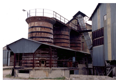
Les fours à surcuit depuis le sud. Phot. Yves Sancey IVR43_19973900380ZA
