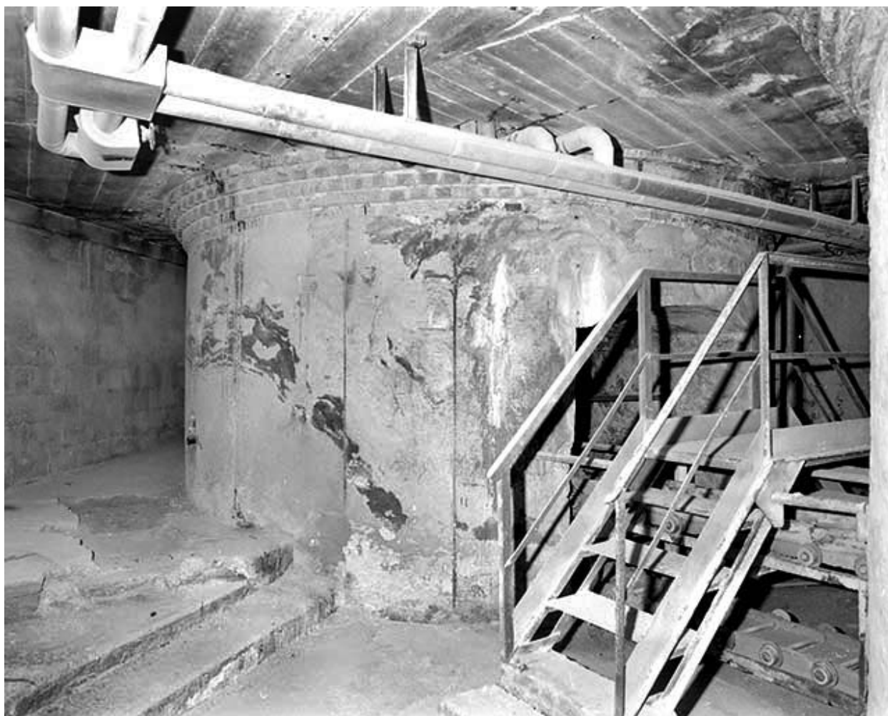
Soubassement d'un four à surcuit.
