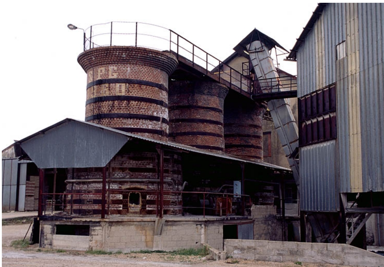
Les fours à surcuit depuis le sud.
