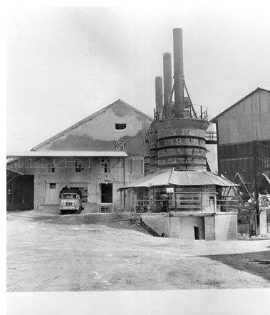
[Atelier de fabrication et fours à surcuit]. Phot. Yves Sancey IVR43_19963901186X
