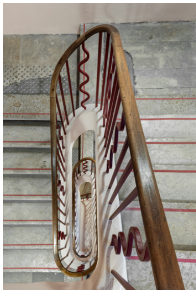
Escalier côté jardin : vue plongeante. Phot. Pierre-Marie Barbe-Richaud IVR26_20245800016NUC4A
