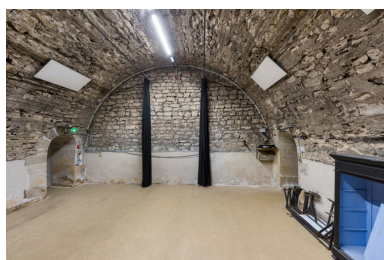
Etage de soubassement, partie centrale : 2e cave, vue de la grande cave. Phot. Pierre-Marie Barbe-Richaud IVR26_20245800023NUC4A
