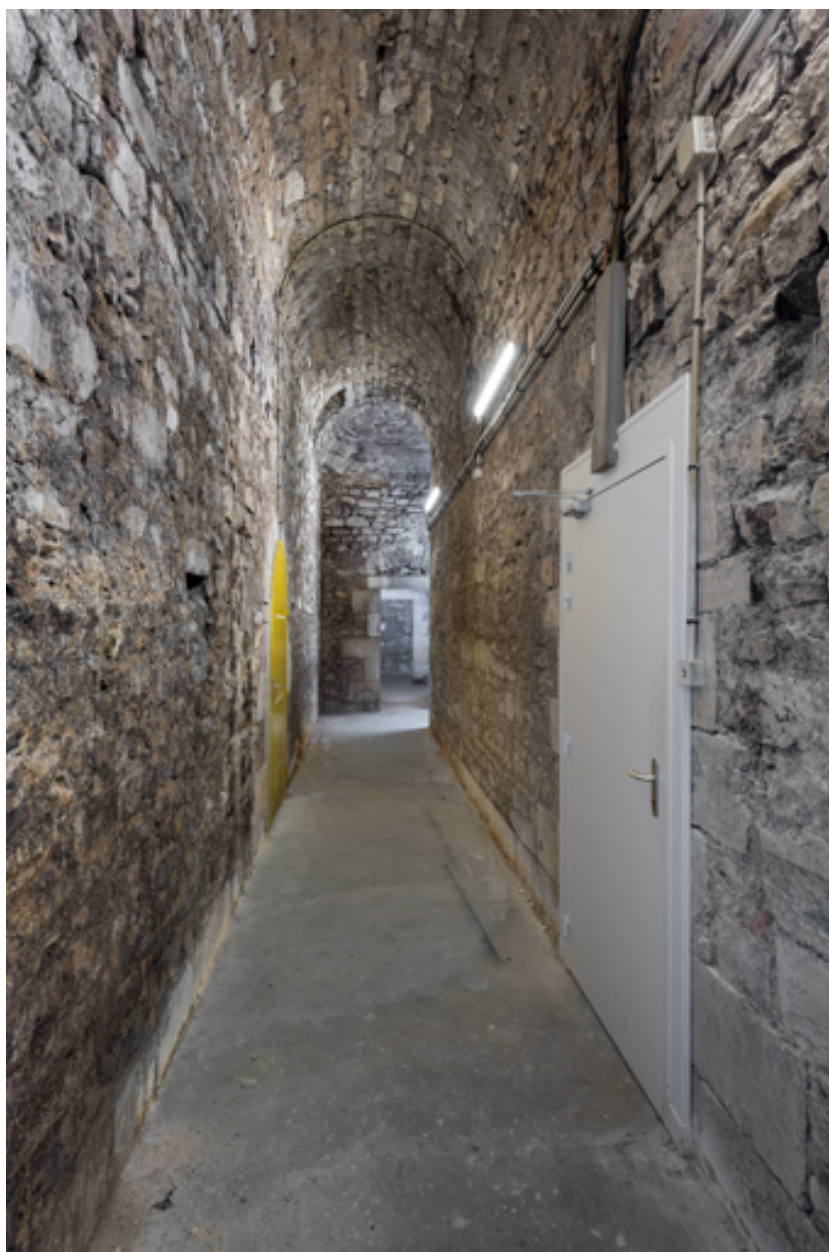
Etage de soubassement, partie gauche : couloir. La porte à droite donne accès à la grande cave.
