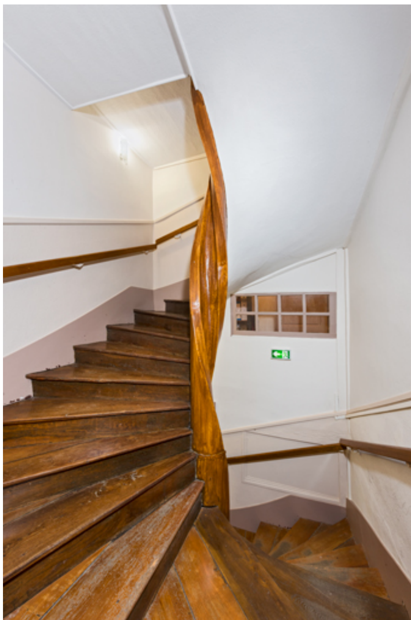
Aile orientale : escalier en vis à limon torse.
