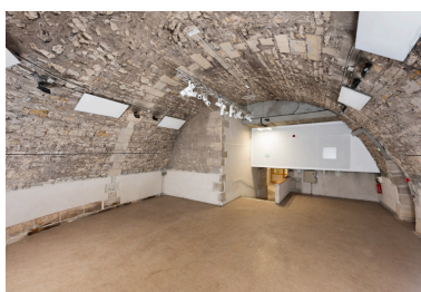
Etage de soubassement, partie centrale : grande cave, vue du fond. Phot. Pierre-Marie Barbe-Richaud IVR26_20245800021NUC4A
