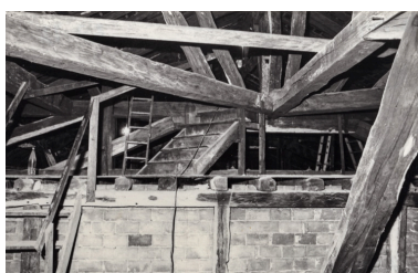
Théâtre, comble, machinerie [comble et charpente]. 2
