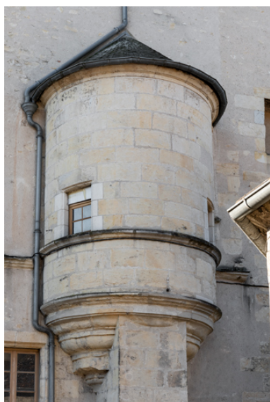
Façade postérieure : échauguette. Phot. Pierre-Marie Barbe-Richaud IVR26_20235800218NUC4A
