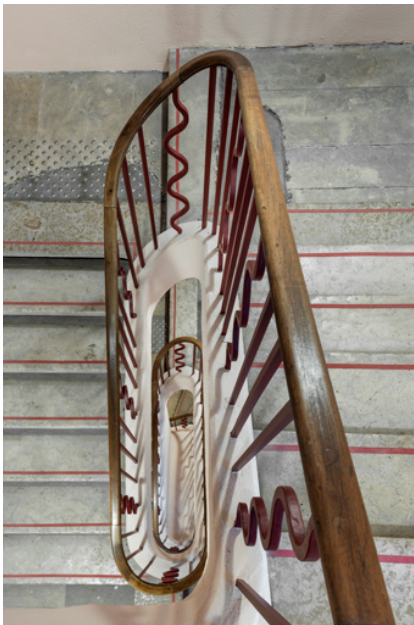
Escalier côté jardin : vue plongeante.
