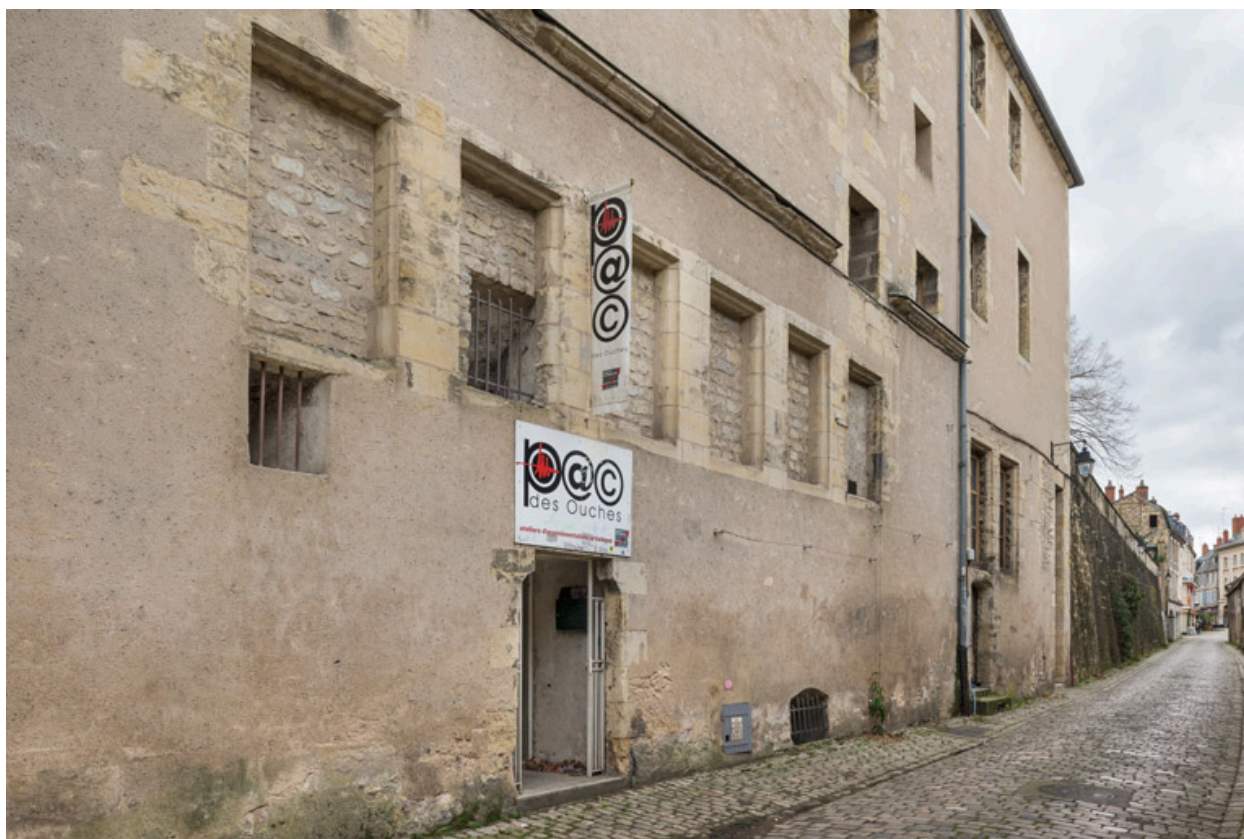
Façade postérieure : parties centrale et droite, vues en enfilade.
