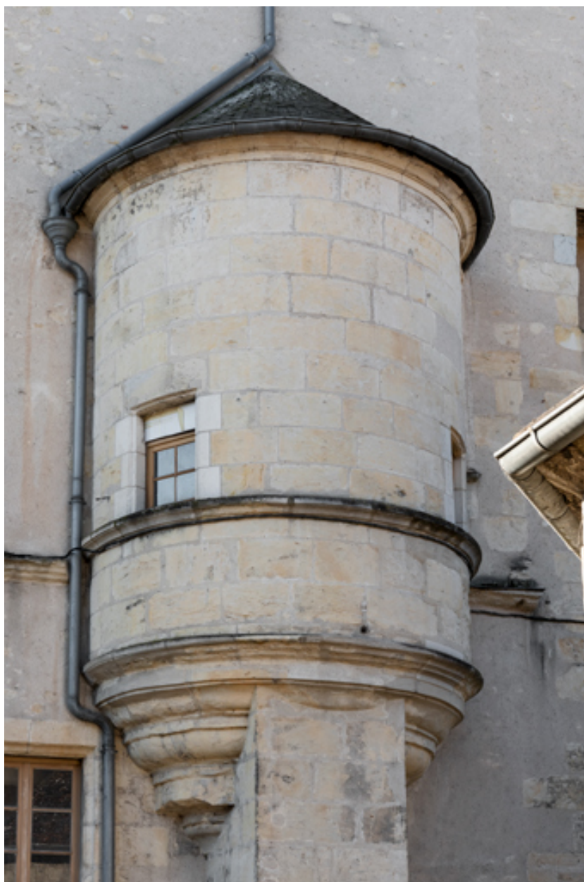
Façade postérieure : échauguette.
