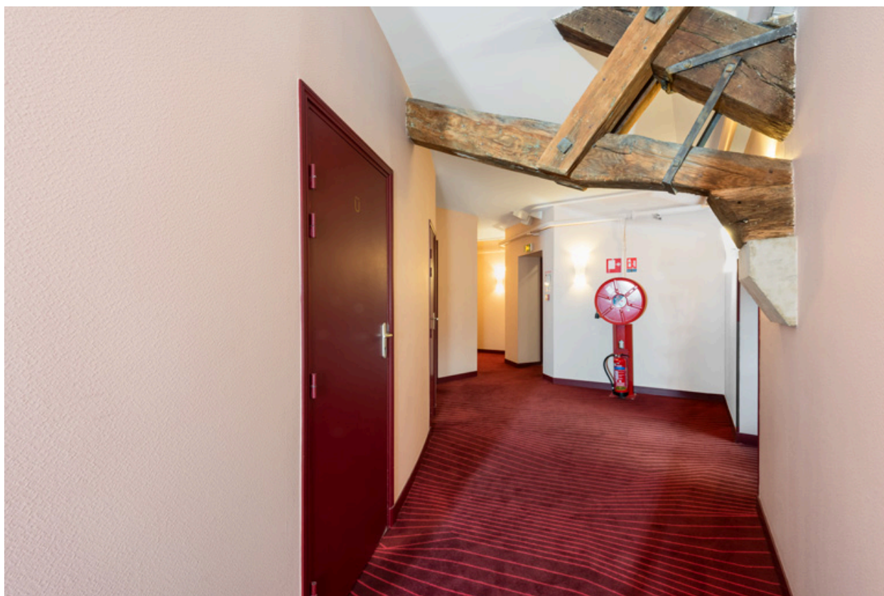
Couloir côté jardin desservant la 3e galerie.
