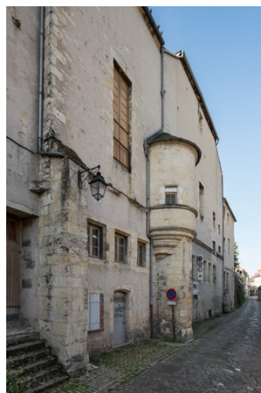
Façade postérieure, vue en enfilade. Phot. Pierre-Marie Barbe-Richaud IVR26_20235800217NUC4A
