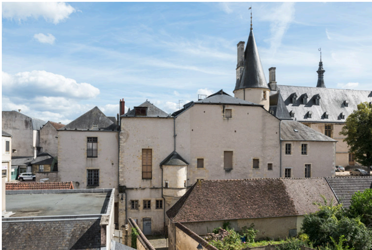
Vue d'ensemble, depuis le nord (façade postérieure).
