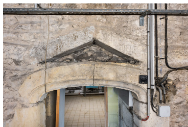
Etage de soubassement, partie droite : entrée de la chaufferie (détail du linteau). Phot. Pierre-Marie Barbe-Richaud IVR26_20245800026NUC4A
