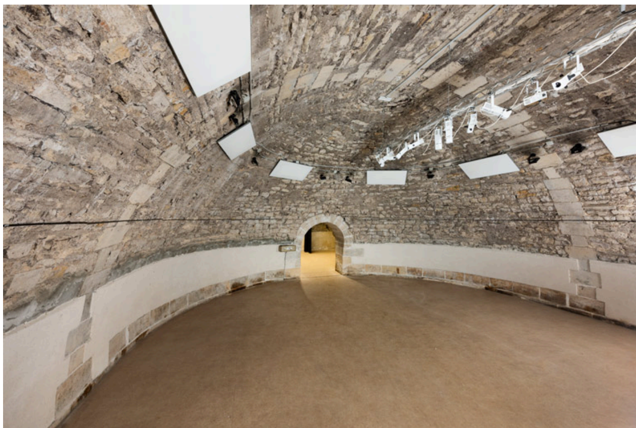
Étage de soubassement, partie centrale : grande cave, vue de l'entrée.
