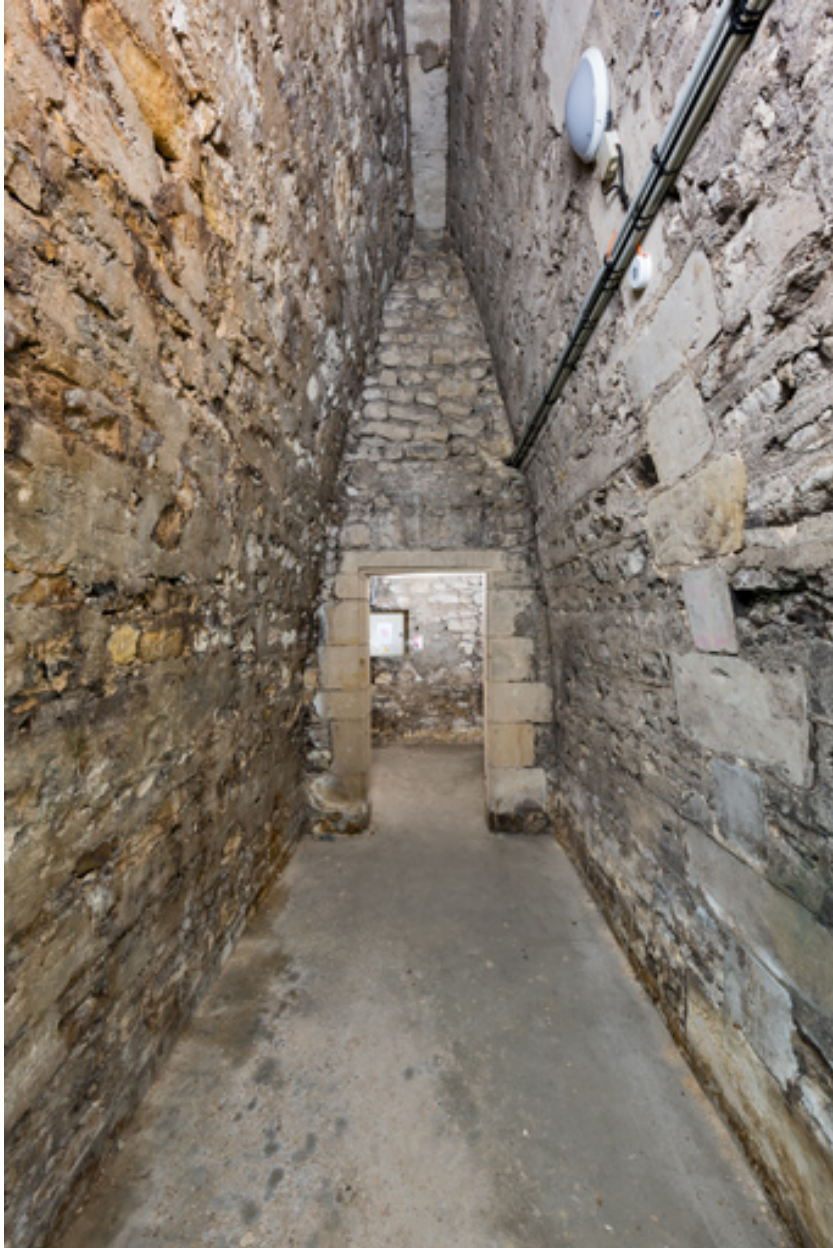
Etage de soubassement, partie gauche : couloir intermédiaire. La 2e cave est accessible par une porte au fond à droite.
