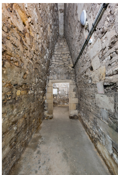
Etage de soubassement, partie gauche : couloir intermédiaire. La 2e cave est accessible par une porte au fond à droite. Phot. Pierre-Marie Barbe-Richaud IVR26_20245800027NUC4A
