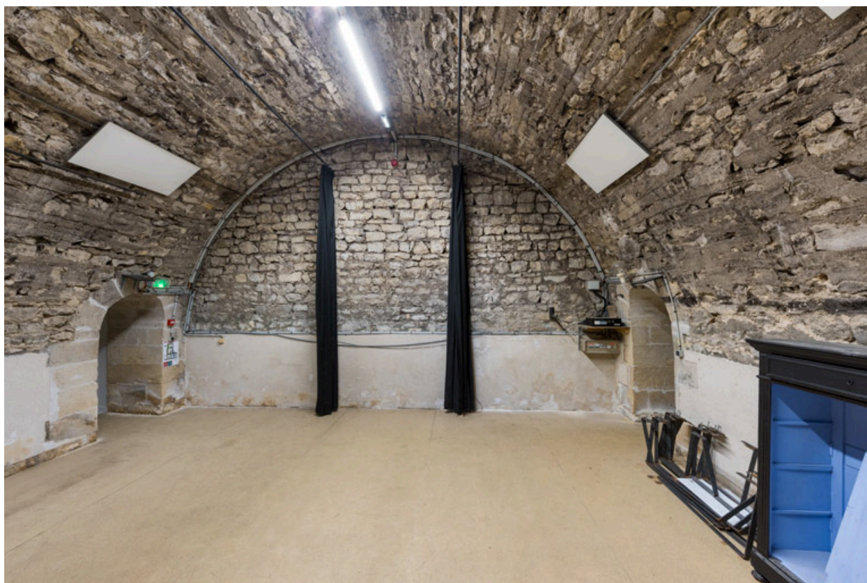
Étage de soubassement, partie centrale : 2e cave, vue de la grande cave.
