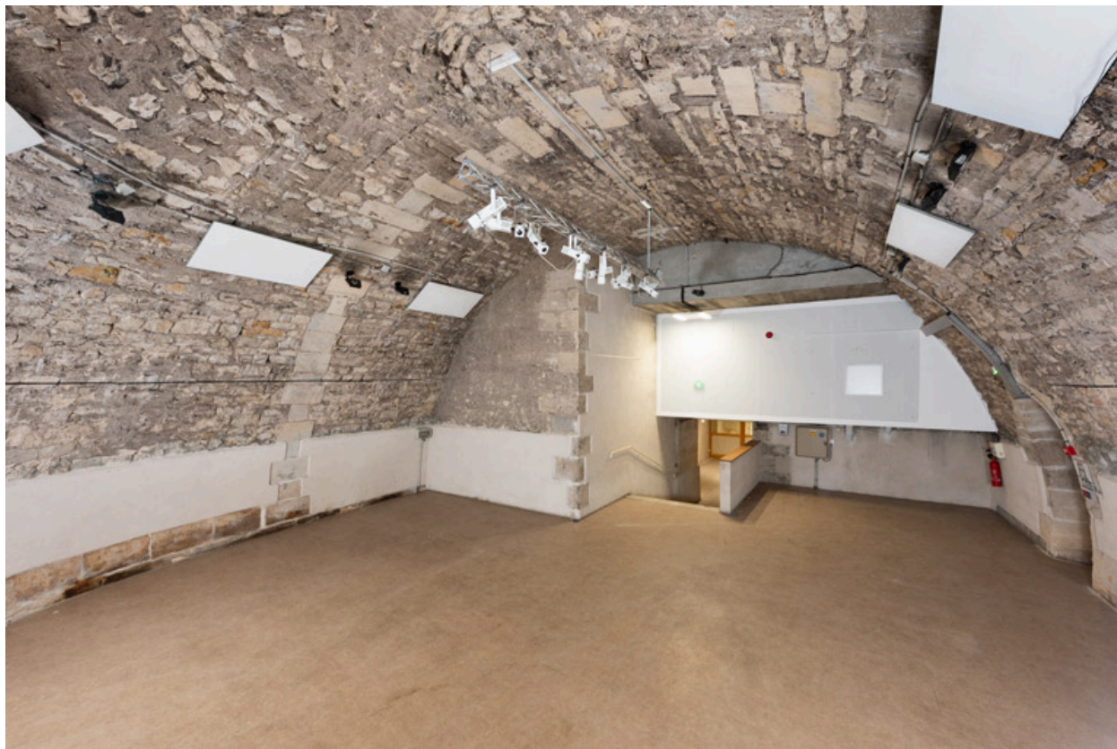
Etage de soubassement, partie centrale : grande cave, vue du fond.
