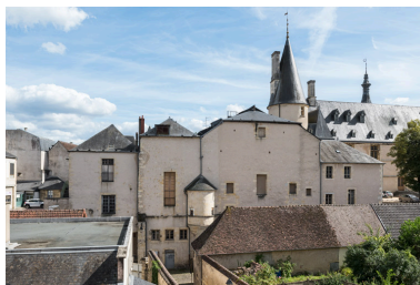
Vue d'ensemble, depuis le nord (façade postérieure). Phot. Pierre-Marie Barbe-Richaud IVR26_20235800276NUC4A
