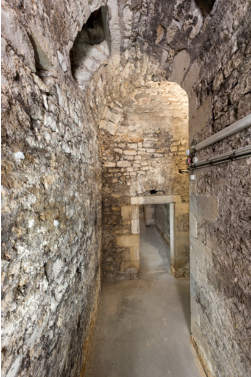
Etage de soubassement, partie gauche : couloir. La porte donne accès au couloir intermédiaire.
