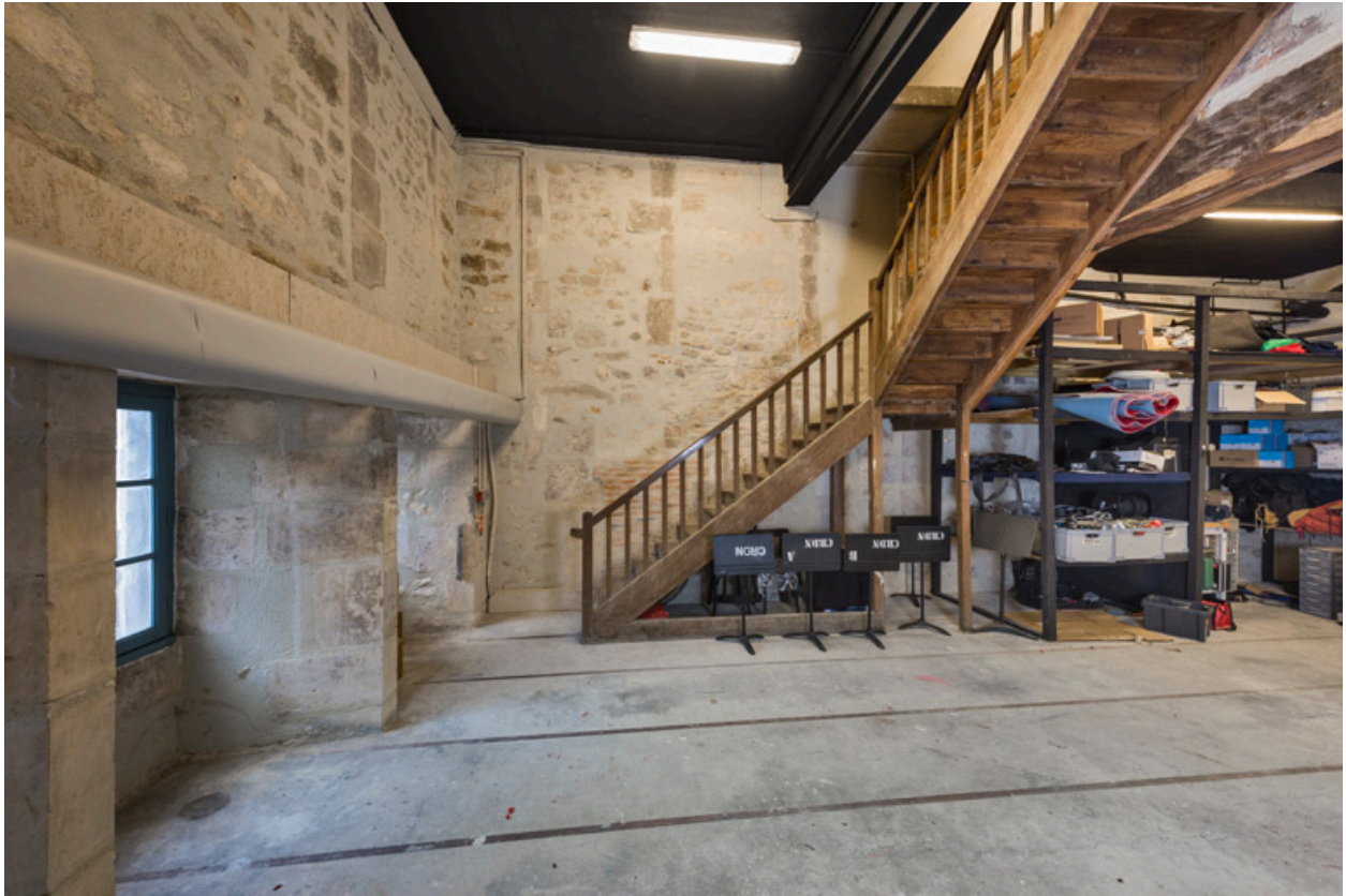
Aile orientale : magasin à l'étage de soubassement.
