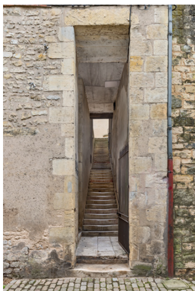
Façade postérieure : escalier reliant la rue des Ouches à l'esplanade du château. Phot. Pierre-Marie Barbe-Richaud IVR26_20245800033NUC4A
