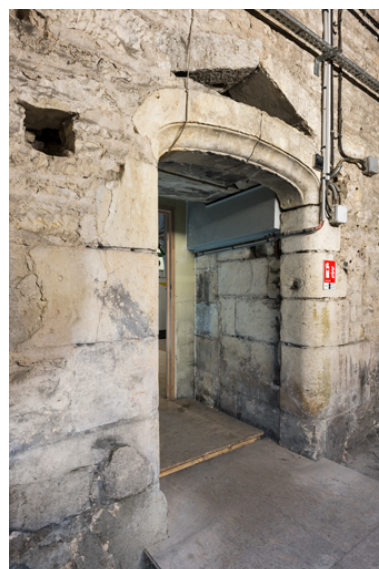
Etage de soubassement, partie droite : entrée de la chaufferie. Phot. Pierre-Marie Barbe-Richaud IVR26_20245800025NUC4A
