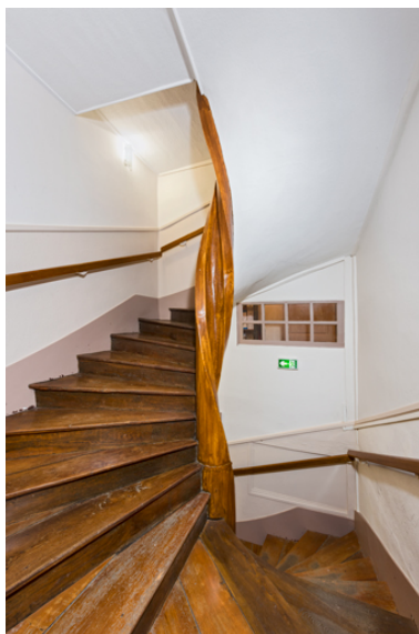
Aile orientale : escalier en vis à limon torse. Phot. Pierre-Marie Barbe-Richaud IVR26_20245800037NUC4A
