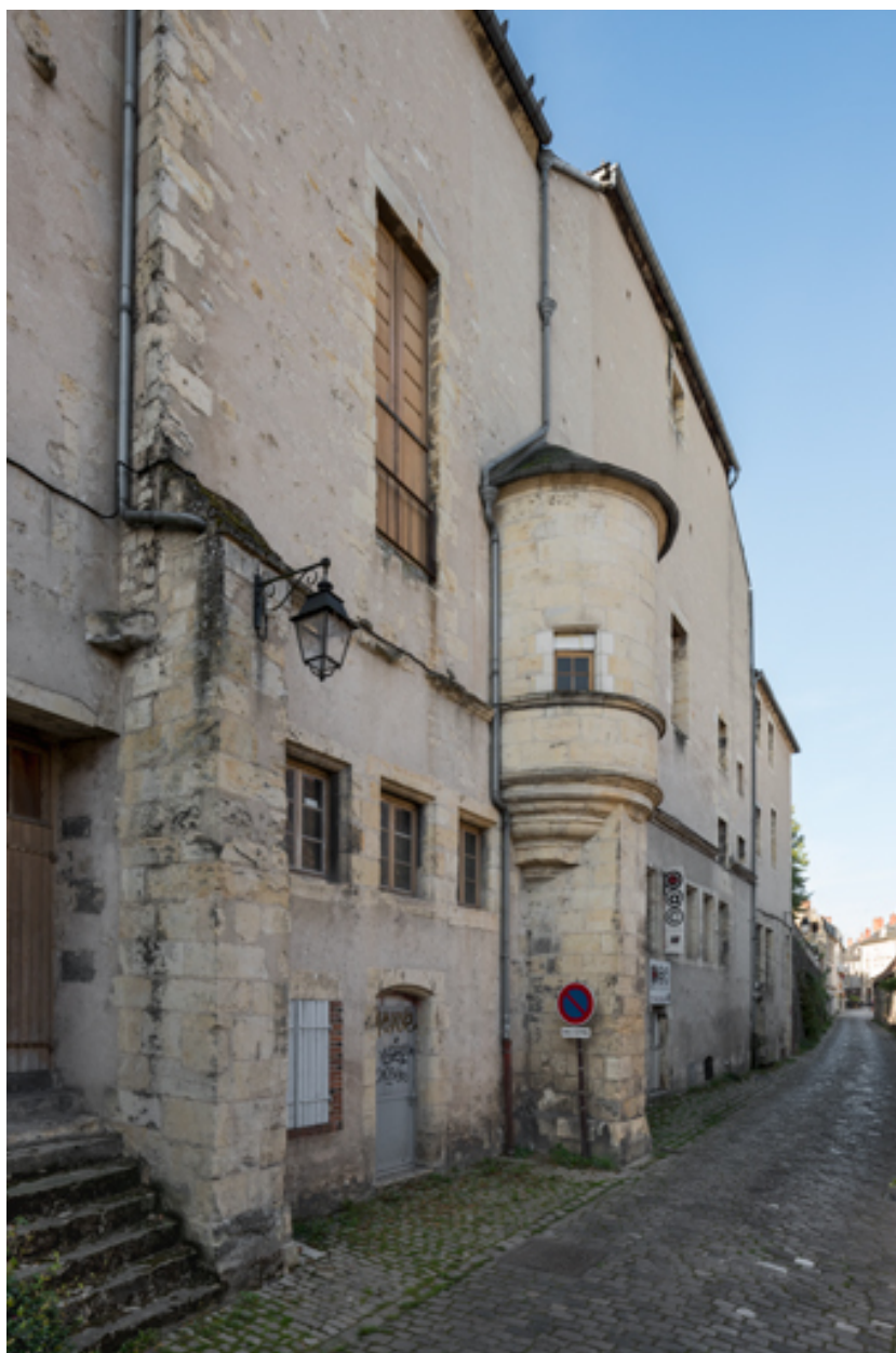
Façade postérieure, vue en enfilade.
