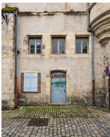
Façade postérieure : partie gauche. Phot. Pierre-Marie Barbe-Richaud IVR26_20245800031NUC4A
