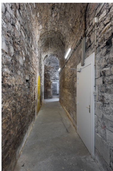
Etage de soubassement, partie gauche : couloir. La porte à droite donne accès à la grande cave. Phot. Pierre-Marie Barbe-Richaud IVR26_20245800029NUC4A
