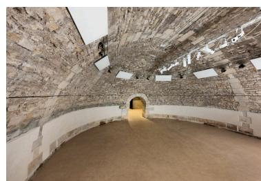
Etage de soubassement, partie centrale : grande cave, vue de l'entrée. Phot. Pierre-Marie Barbe-Richaud IVR26_20245800022NUC4A
