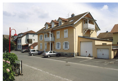
Logements collectifs rue Kléber. Phot. Yves Sancey IVR43_20019000322ZA
