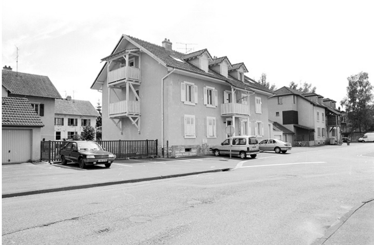
Logements collectifs (1902) rue Kléber.
