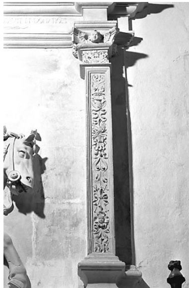
Détail : pilastre droit. Phot. Yves Sancey IVR43_19782500823Z
